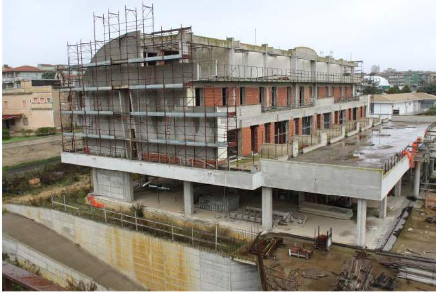
La copertura è costituita in parte da un solaio curvo che ricopre il terzo livello, sotto tetto e per la restante parte da una terrazza piana.
