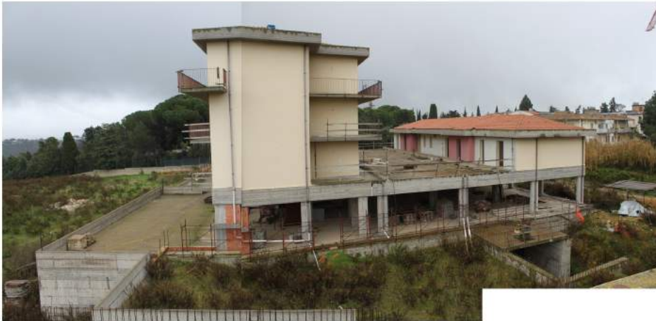
EDIFICIO A FOTO 10
