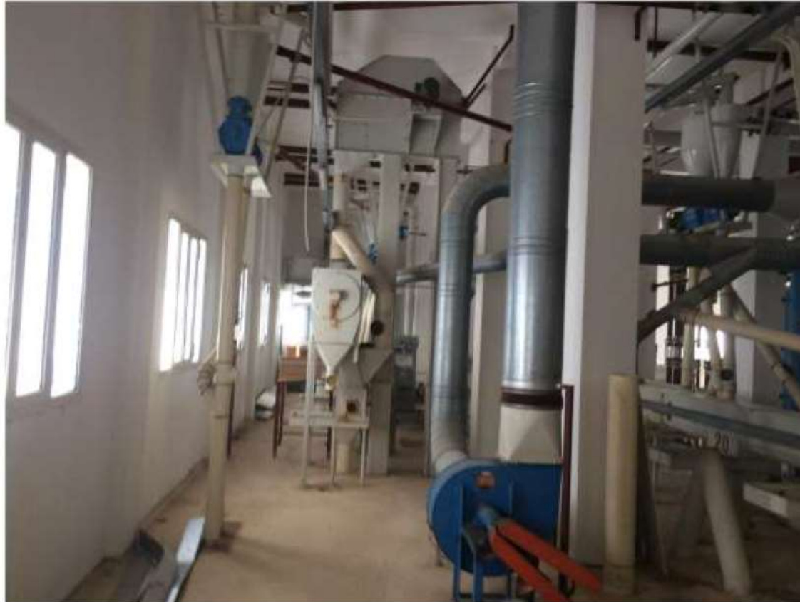
Figura 24 - Vista interna piano Quarto
