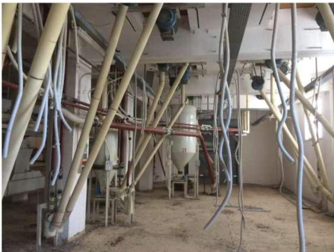
Figura 5 - Vista interna piano Terra
