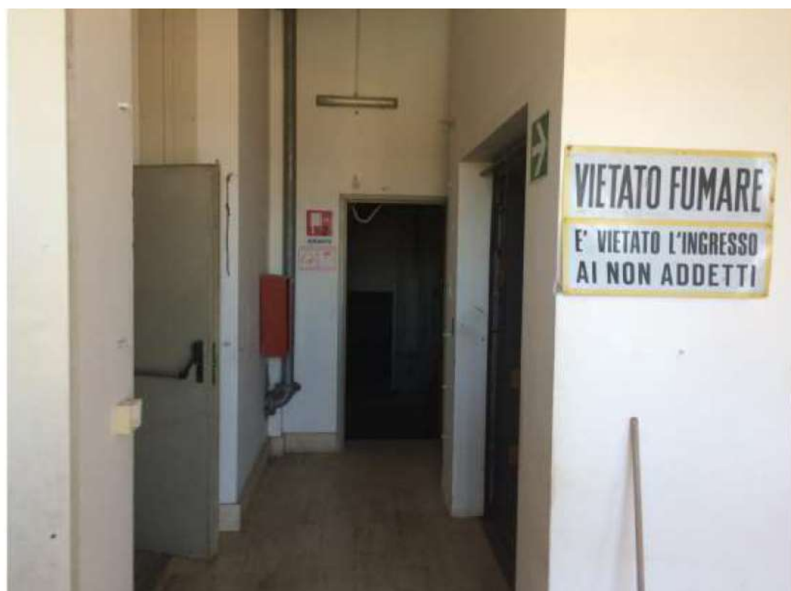
Figura 4 - Vista interna piano Terra
