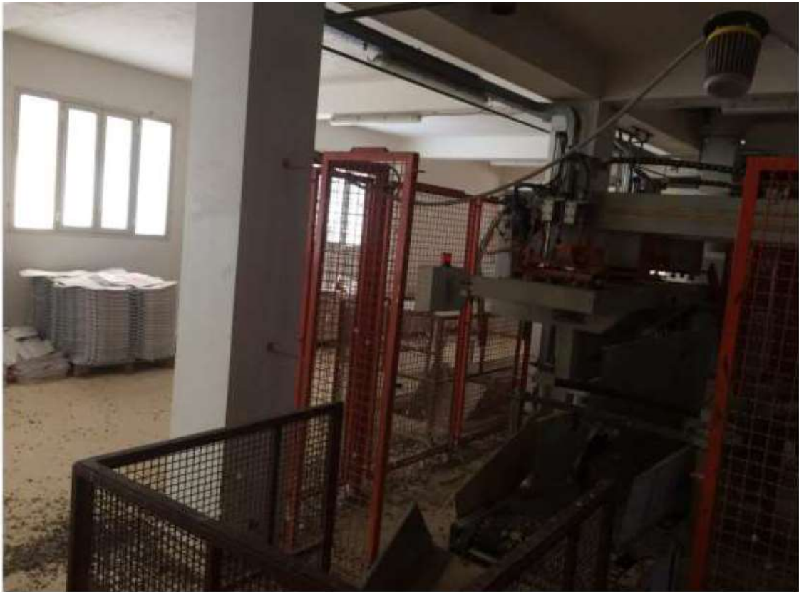
Figura 11 - Vista interna piano Primo
