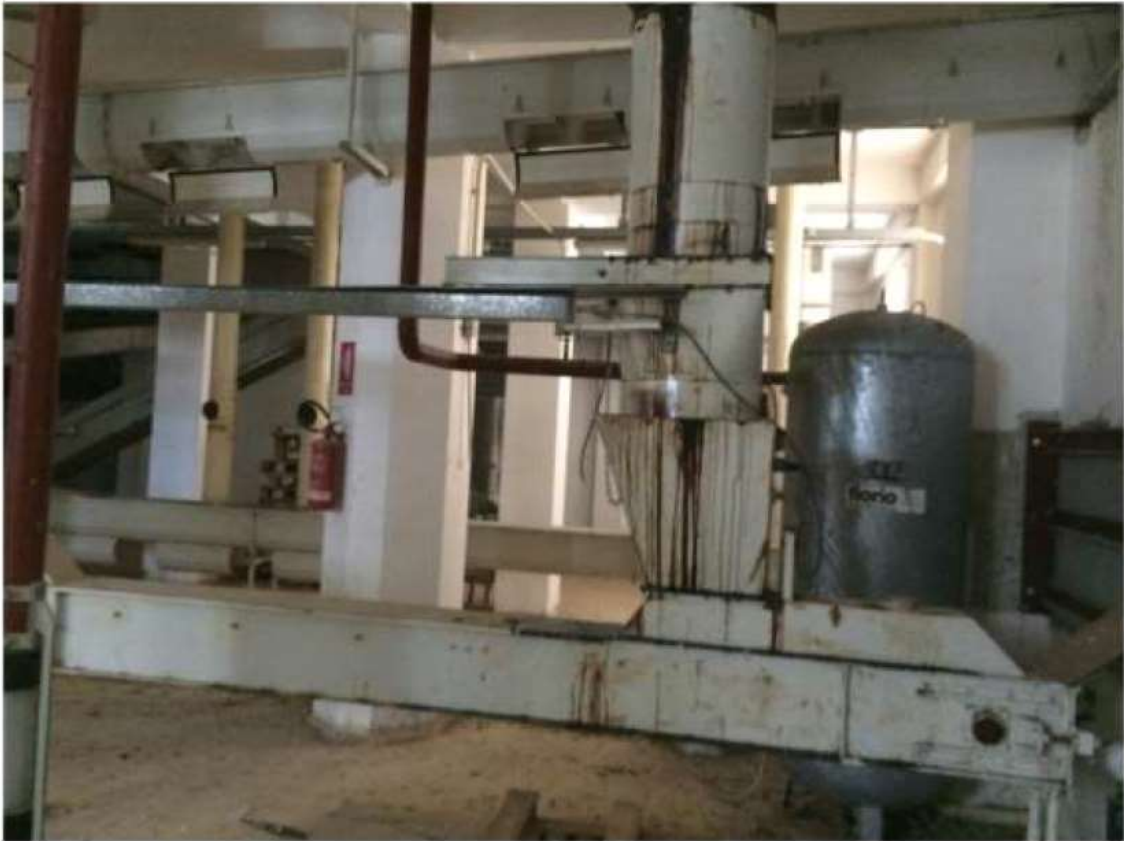
Figura 6 - Vista interna piano Terra
