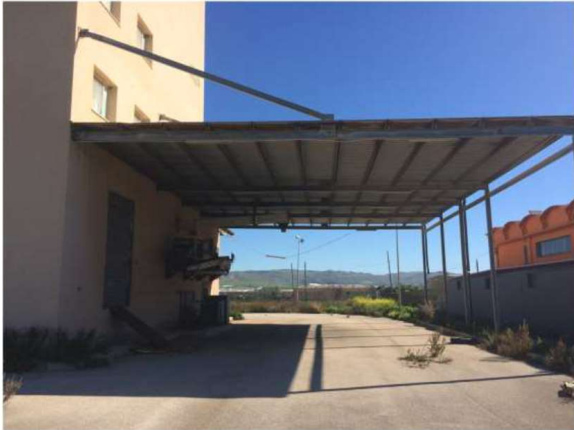
Figura 9 - Vista esterna piano Terra tettoia
