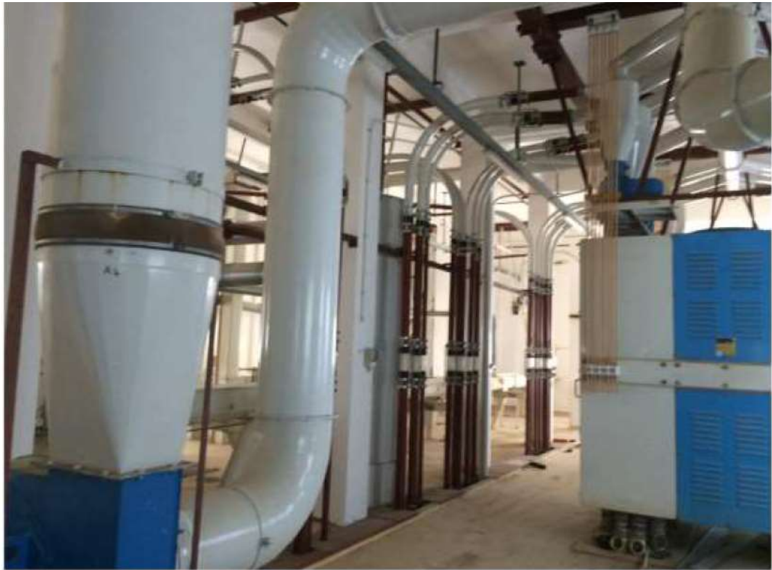
Figura 25 - Vista interna piano Quarto
