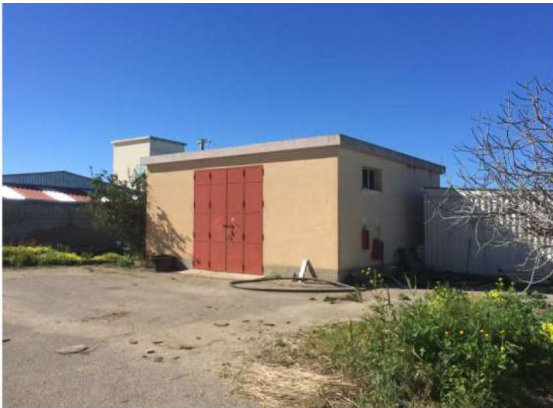
Figura 8 - Vista esterna del magazzino
