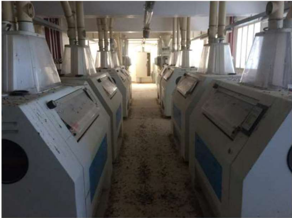
Figura 17 - Vista interna piano Primo
