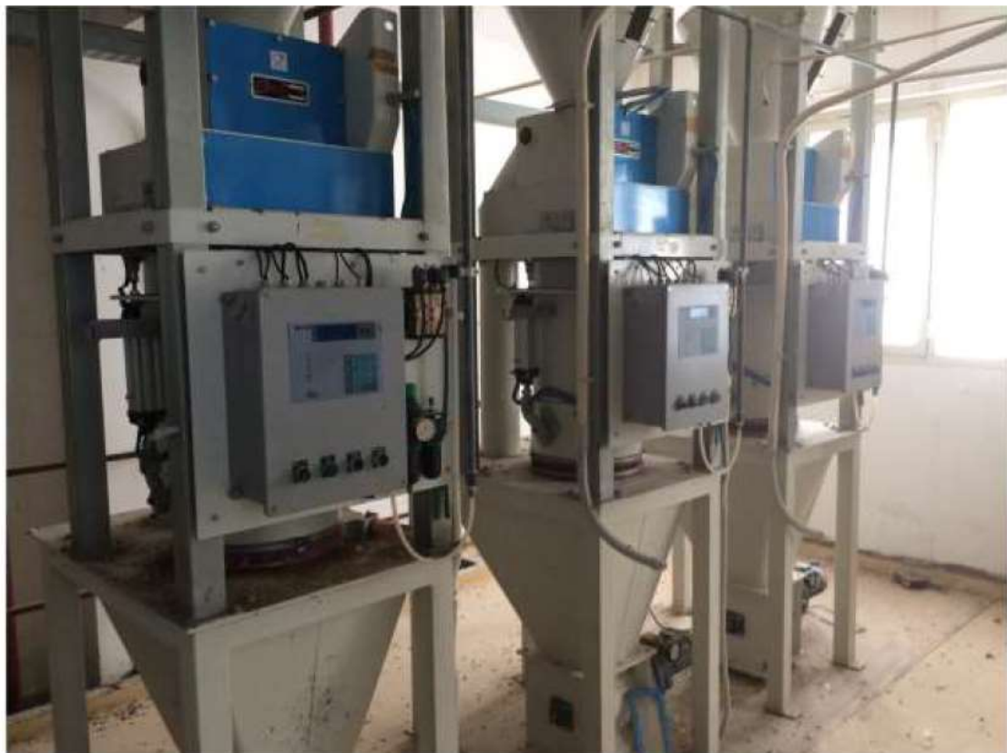
Figura 14 - Vista interna piano Primo
