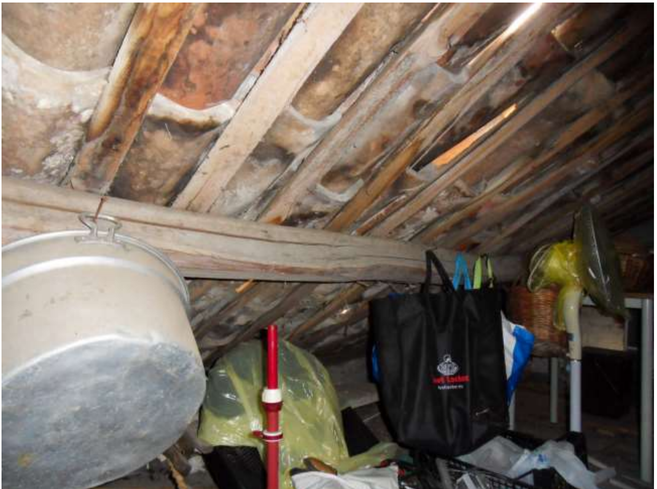
FOTO N. 40: Interni Immobile – Sottotetto
