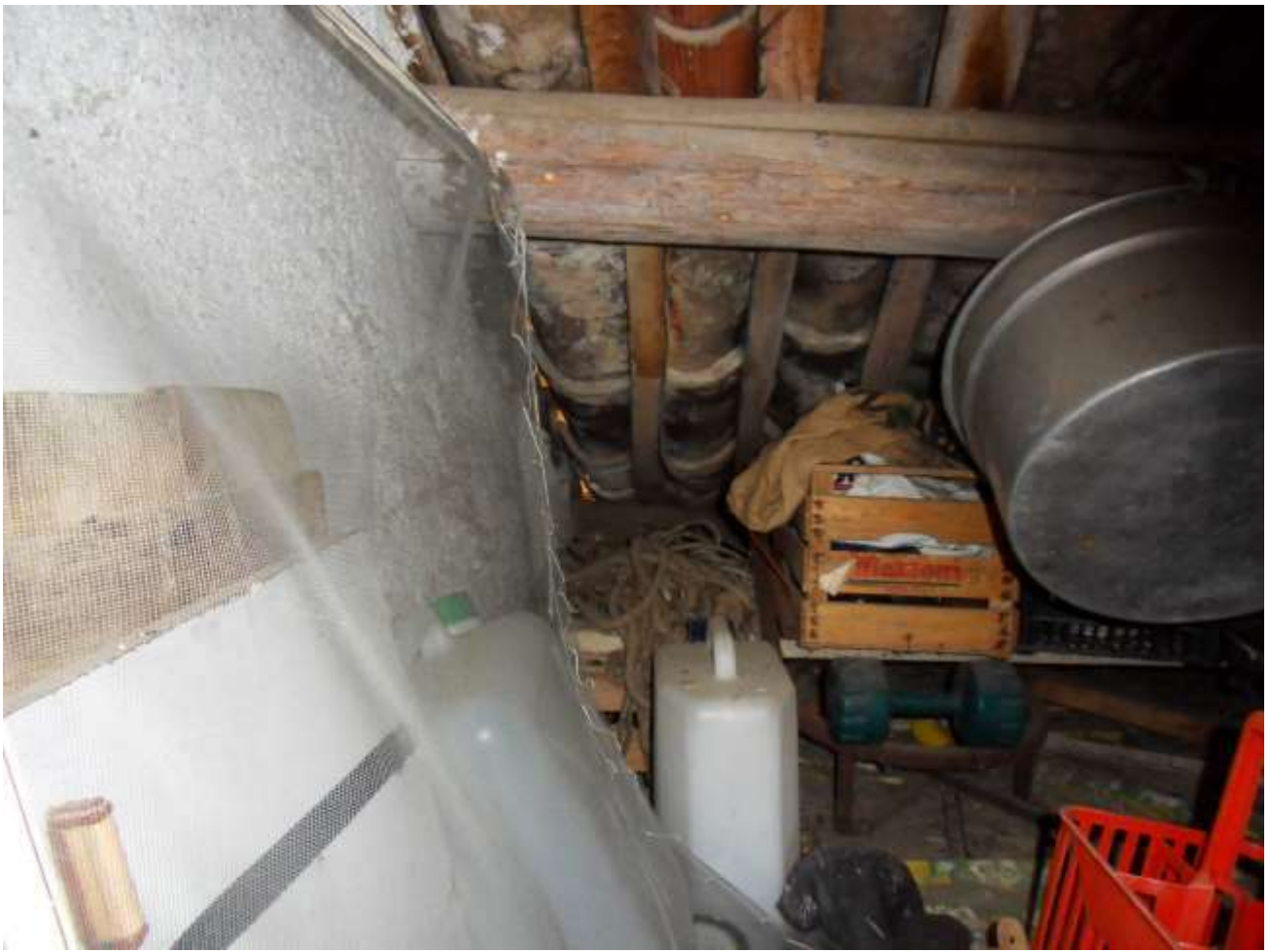
FOTO N. 41: Interni Immobile – Sottotetto
