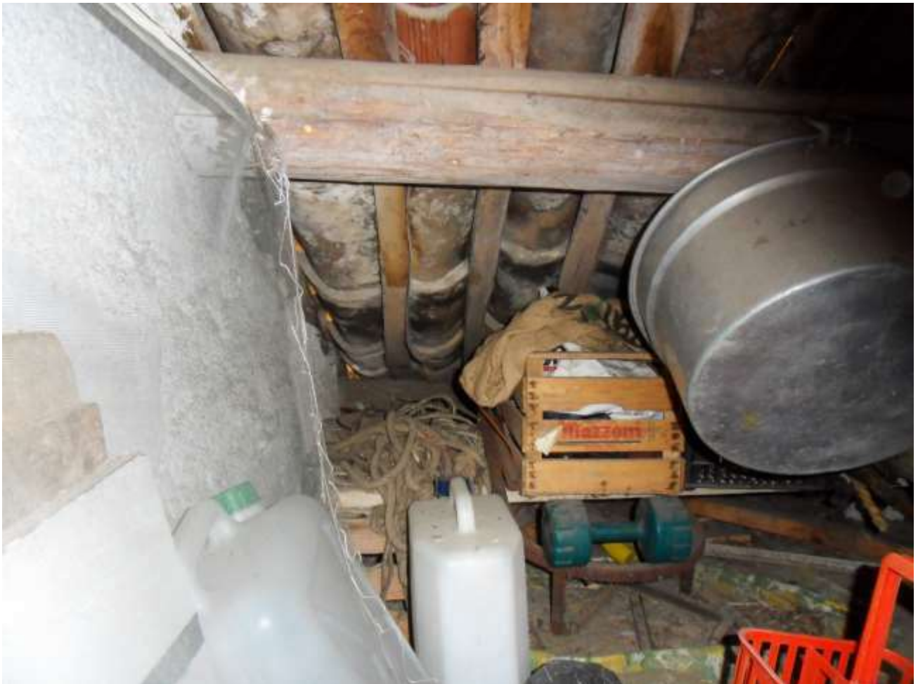
FOTO N. 38: Interni Immobile – Sottotetto
