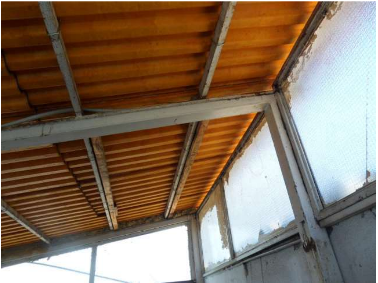
FOTO N. 34: Interni Immobile – Terrazzo
