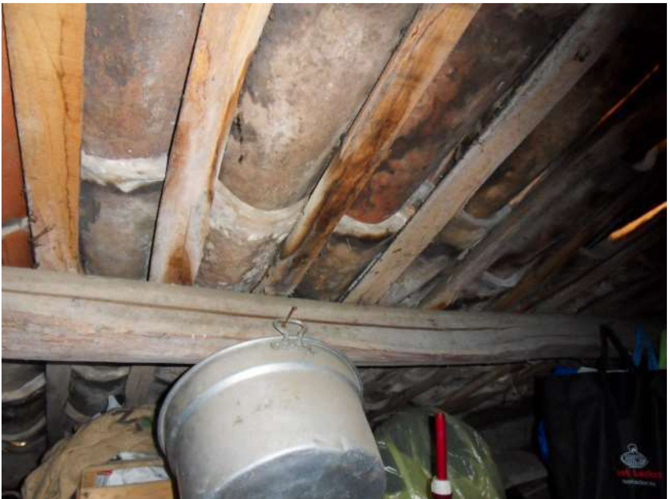
FOTO N. 42: Interni Immobile – Sottotetto
