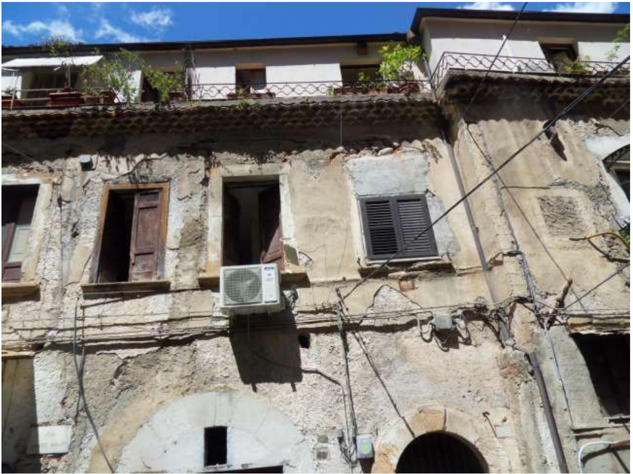
FOTO N. 1: Prospetto SUD-OVEST del Fabbricato
