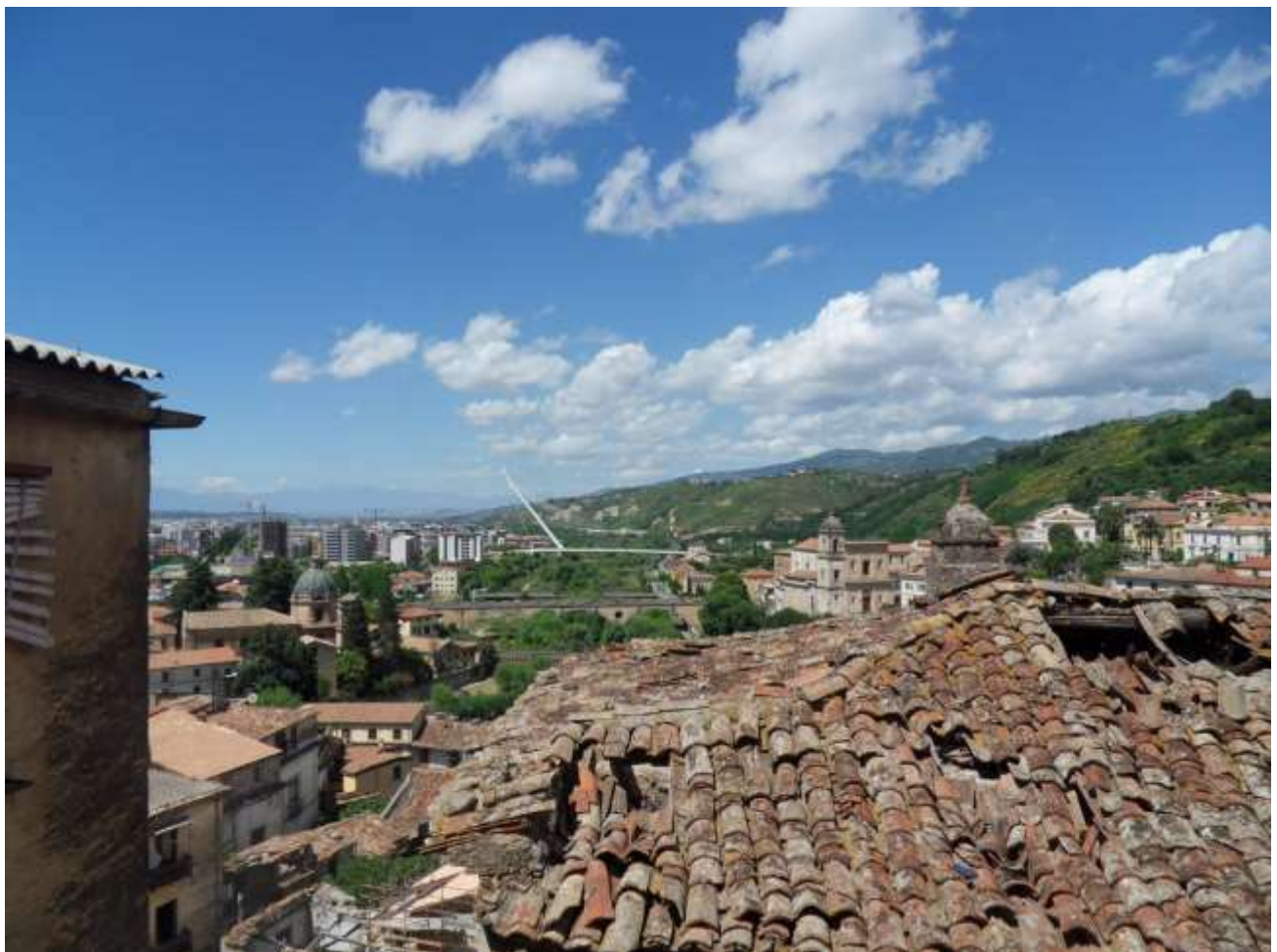
FOTO N. 60: Vista in Direzione NORD – OVEST da immobile
