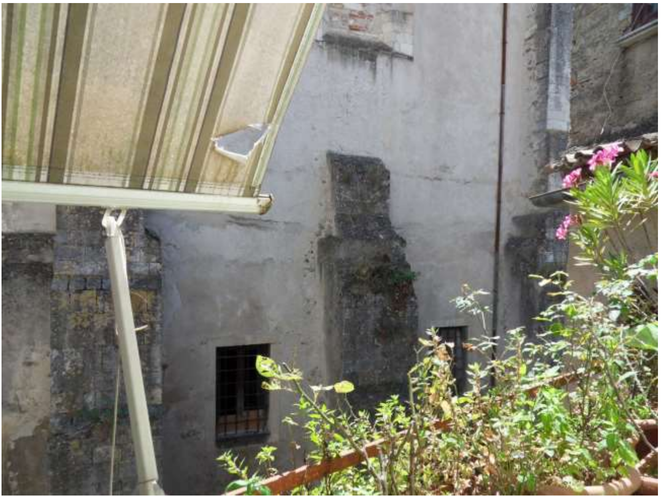
FOTO N. 63: Vista in Direzione SUD - OVEST da immobile
