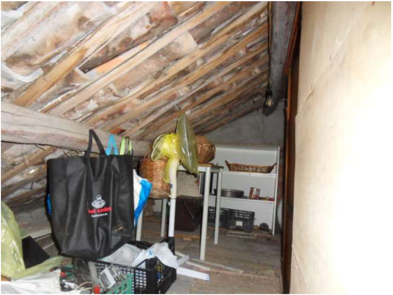
FOTO N. 39: Interni Immobile – Sottotetto
