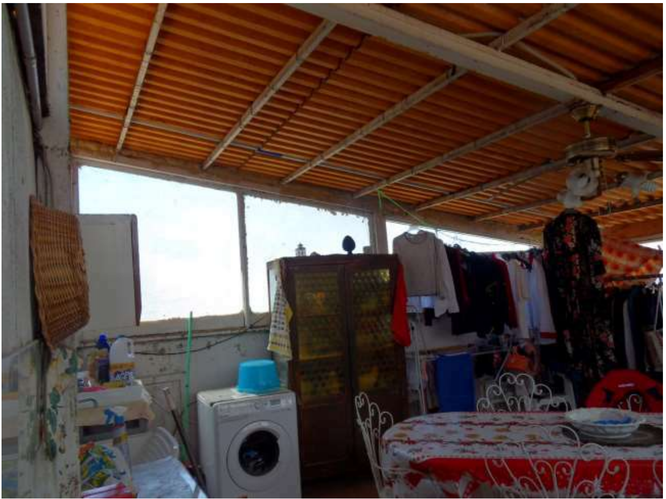
FOTO N. 45: Interni Immobile – Terrazzo
