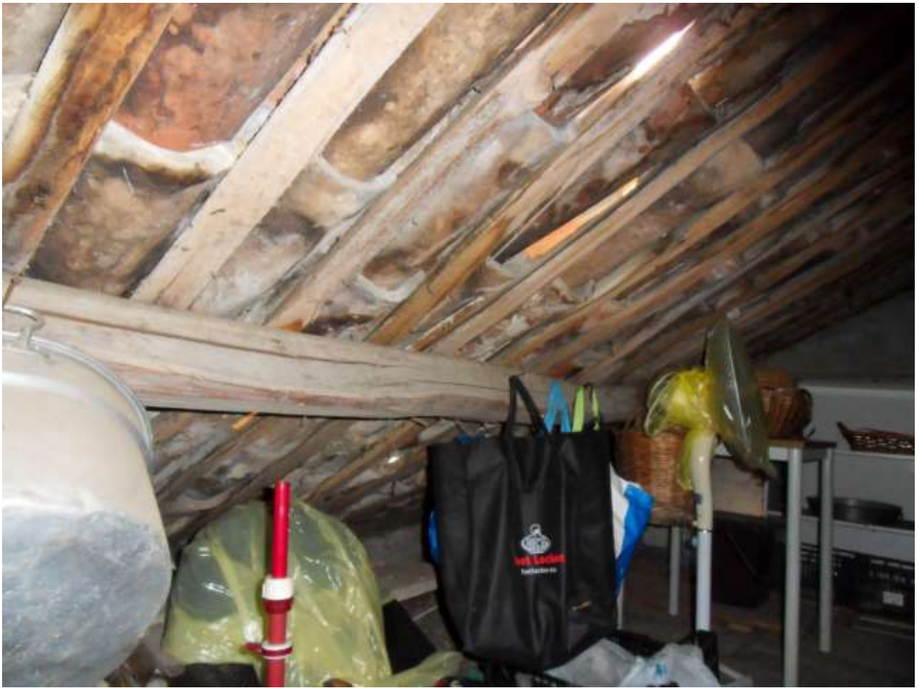
FOTO N. 43: Interni Immobile – Sottotetto
