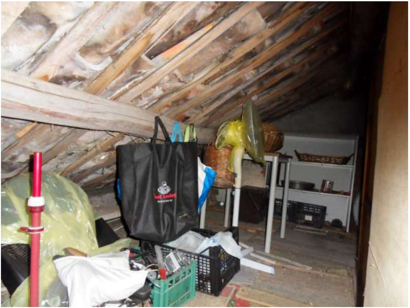
FOTO N. 37: Interni Immobile – Sottotetto
