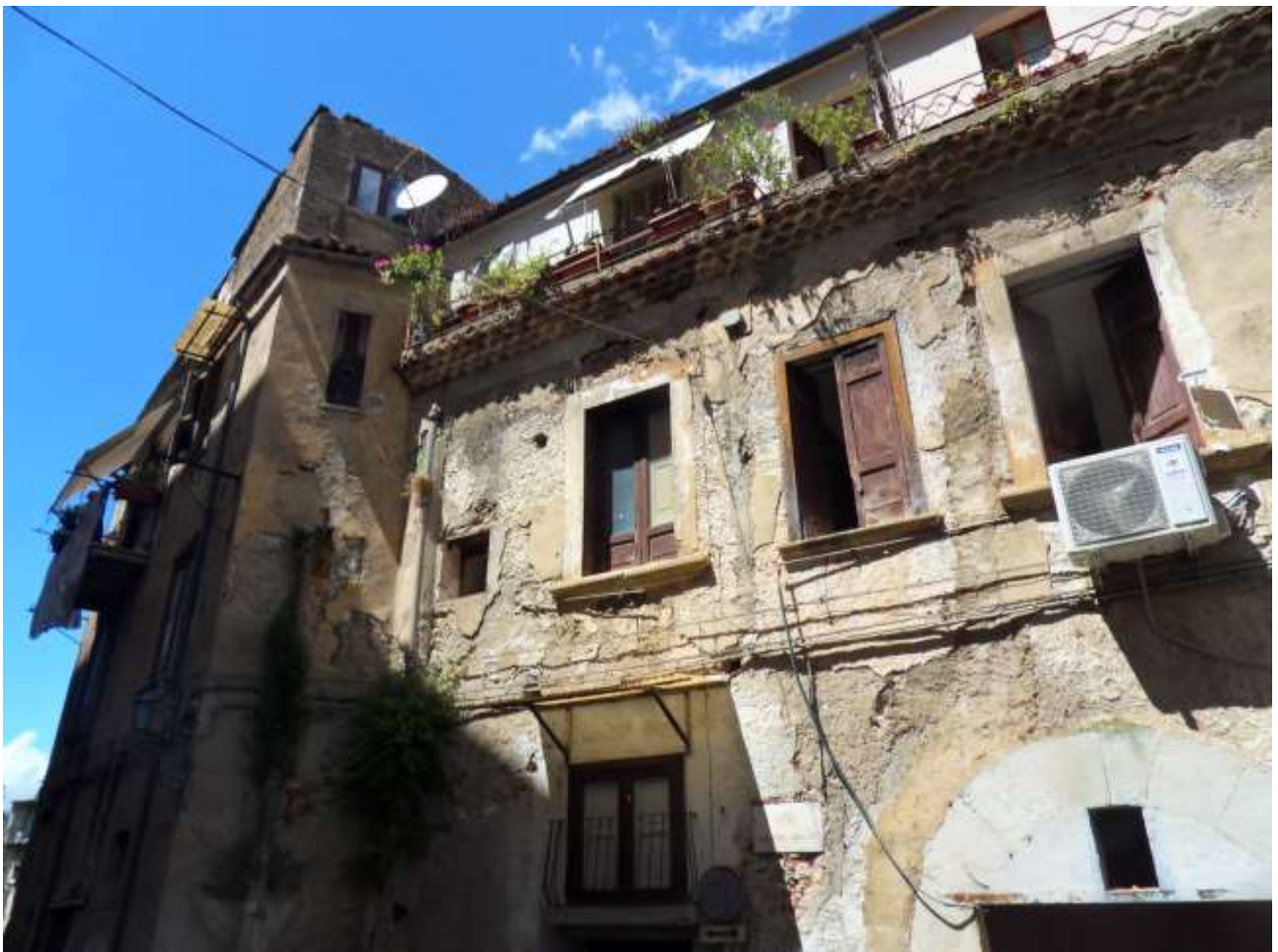
FOTO N. 2: Prospetto SUD-OVEST del Fabbricato
