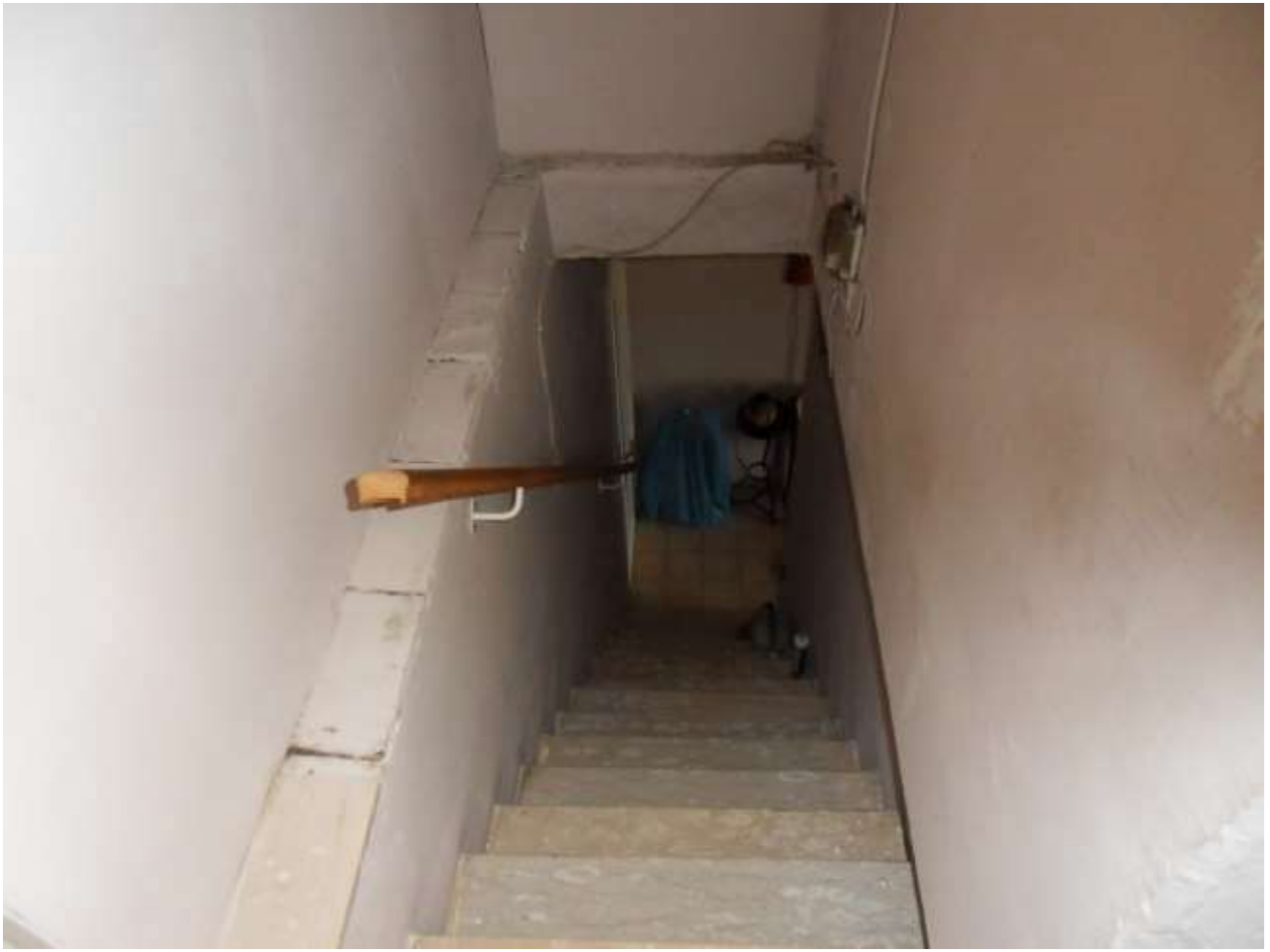
FOTO N. 27: Interni Immobile – Vano Scala per Terrazzo e Sottotetto
