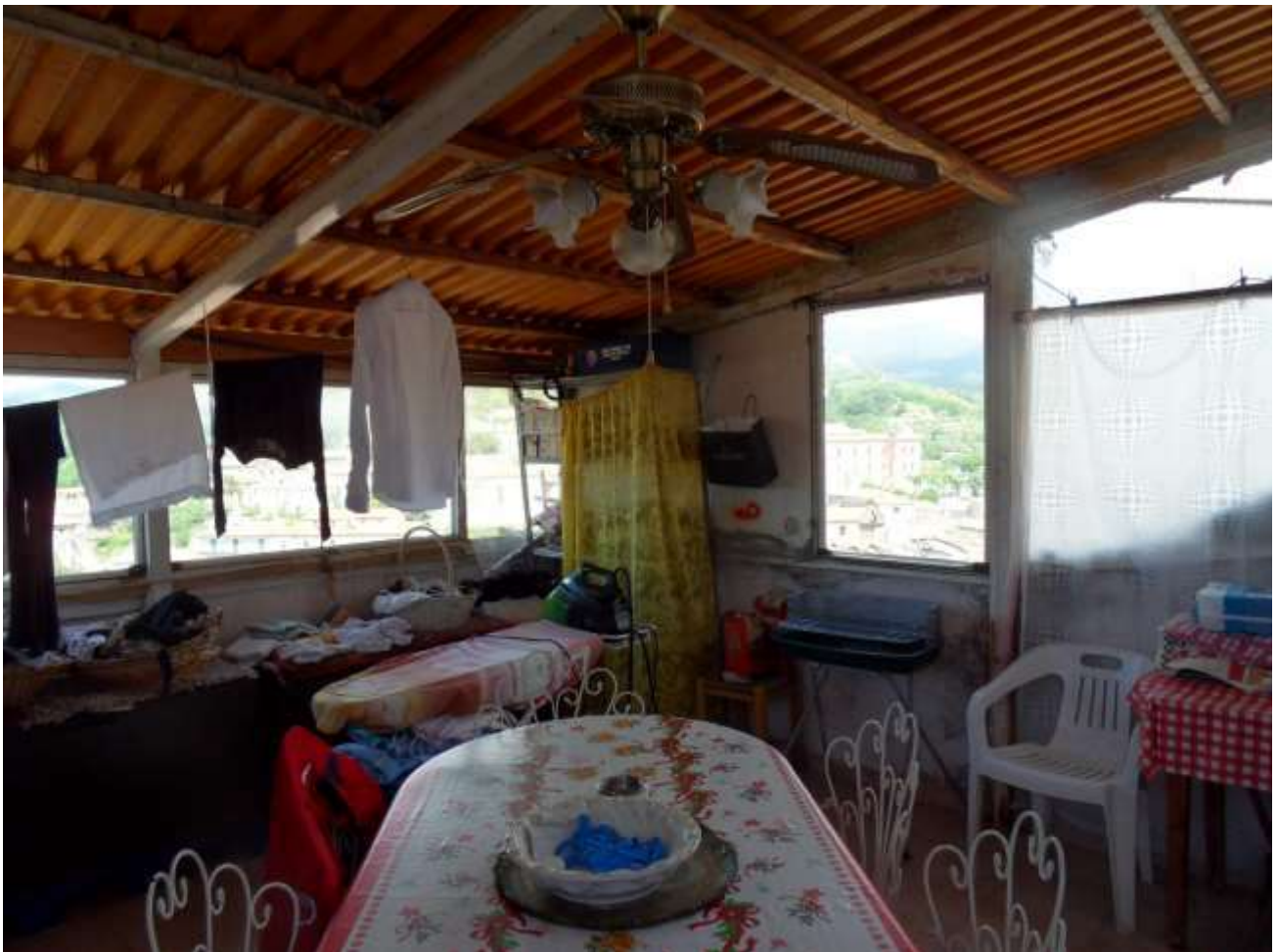
FOTO N. 32: Interni Immobile – Terrazzo
