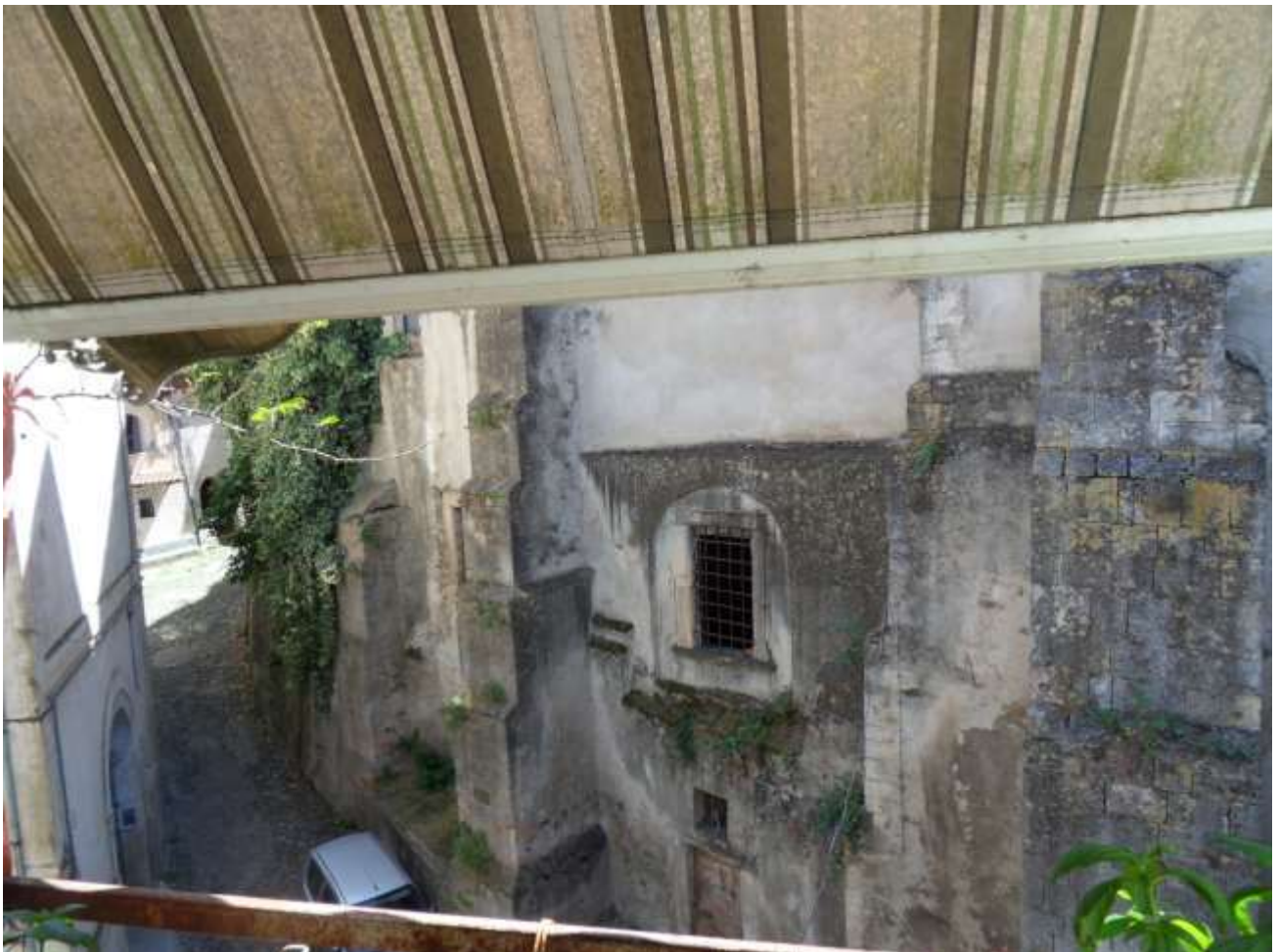
FOTO N. 64: Vista in Direzione SUD - EST da immobile
