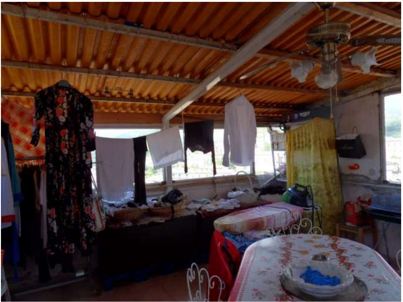
FOTO N. 33: Interni Immobile – Terrazzo
