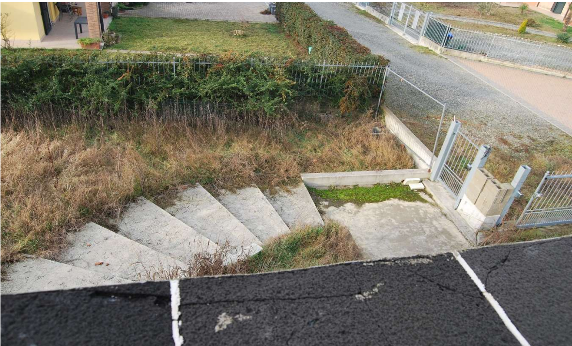
Disimpegno e scala accesso al P 1°, scaletta esterna , via Kennedy, Quargento (AL) foto 19-20)
