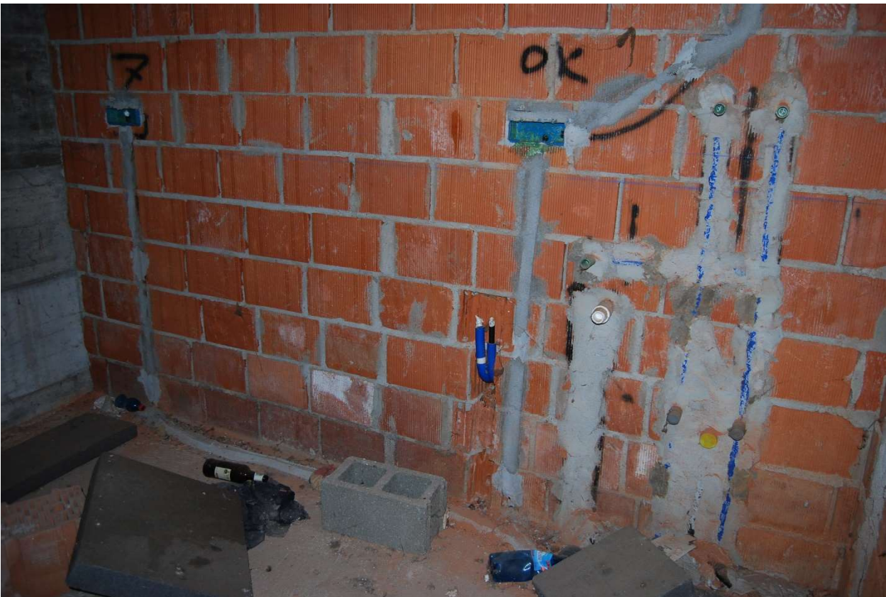
Predisposizione impianti tecnologici, via Kennedy, Quargento (AL) foto 15-16)
