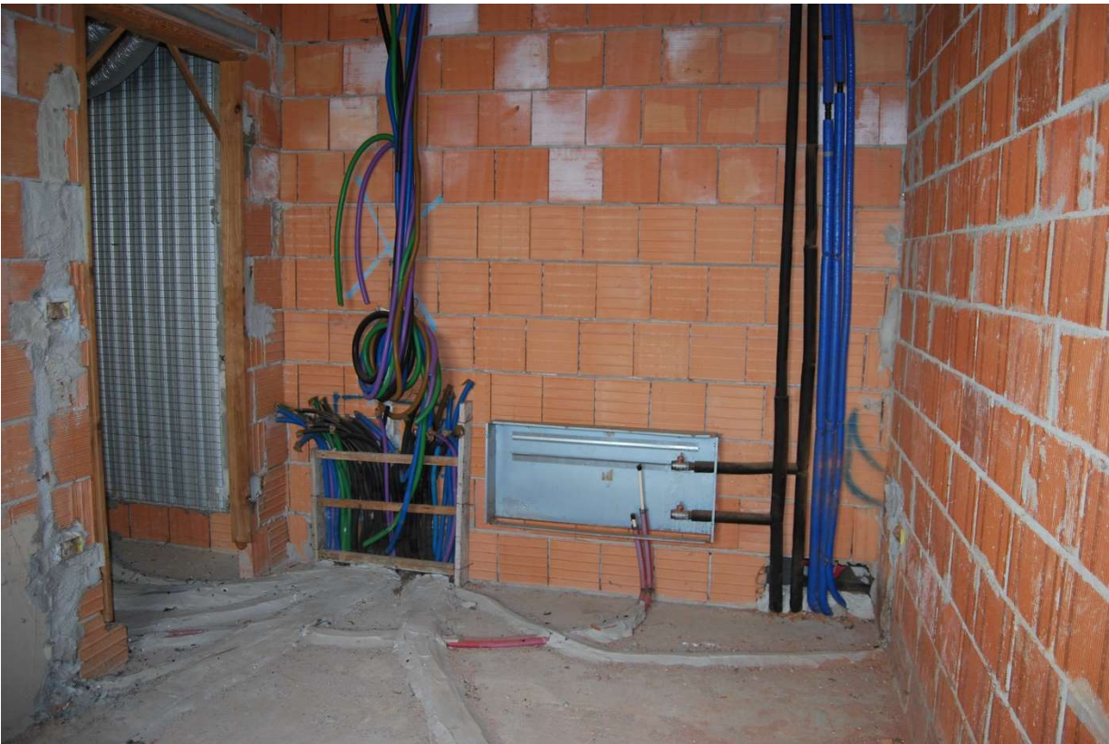
Predisposizione impianti tecnologici, via Kennedy, Quargento (AL) foto 11-12)
