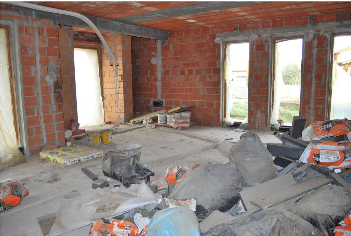
Scala d'accesso P 1° e locale soggiorno, via Kennedy, Quargnento (AL) foto 9-10)
