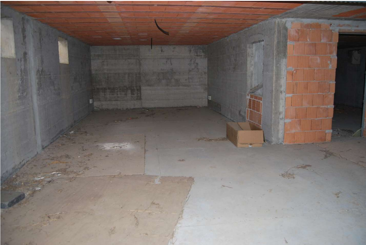
Basculante per autorimessa e locale cantina e sgombero, via Kennedy, Quargnento (AL) foto 7-8)
