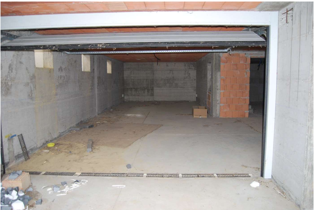
Rampa d'accesso e ingresso con basculante per autorimessa, via Kennedy, Quargento (AL) foto 5-6)
