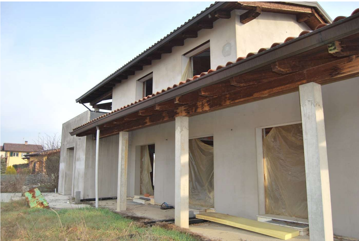
Facciate esterne fabbricato residenziale in costruzione, via Kennedy, Quargnento (AL) foto 1-2)
