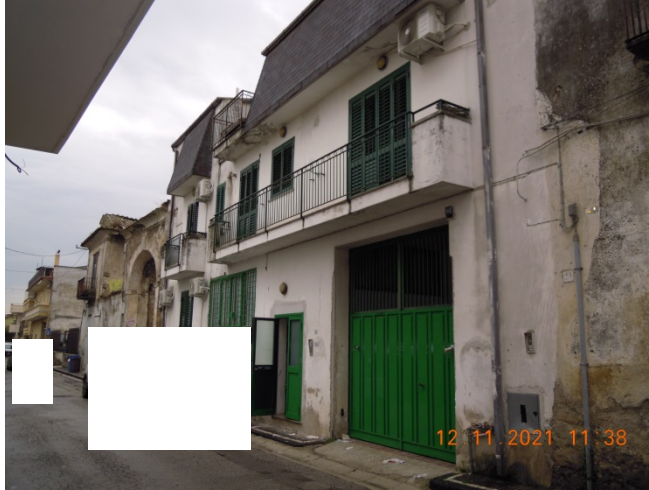
Vista da Via Chiesa Foto 1
