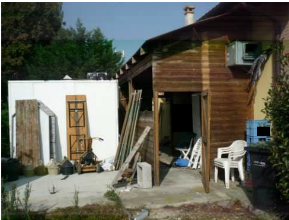
Locale ripostiglio in legno dimensioni ml 3,00 x ml 6,00 Opera abusivamente realizzata da demolire PROSPETTO SUD/EST
