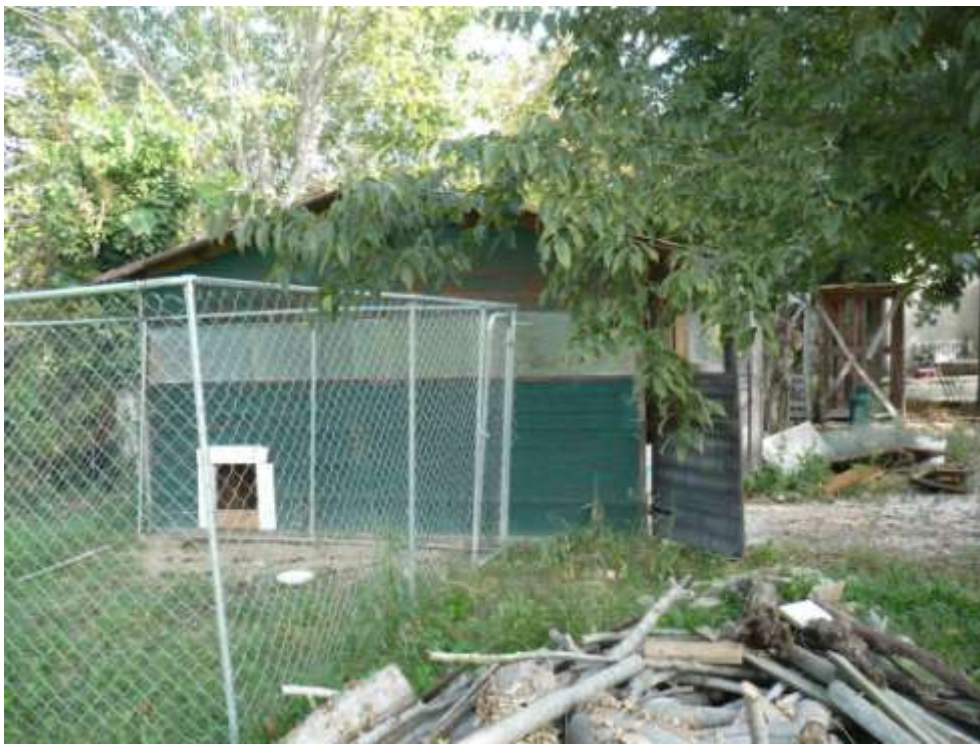
Locale ricovero attrezzi in legno dimensioni ml 4,20 x ml 11,00 Opera abusivamente realizzata da demolire PROSPETTO NORD
