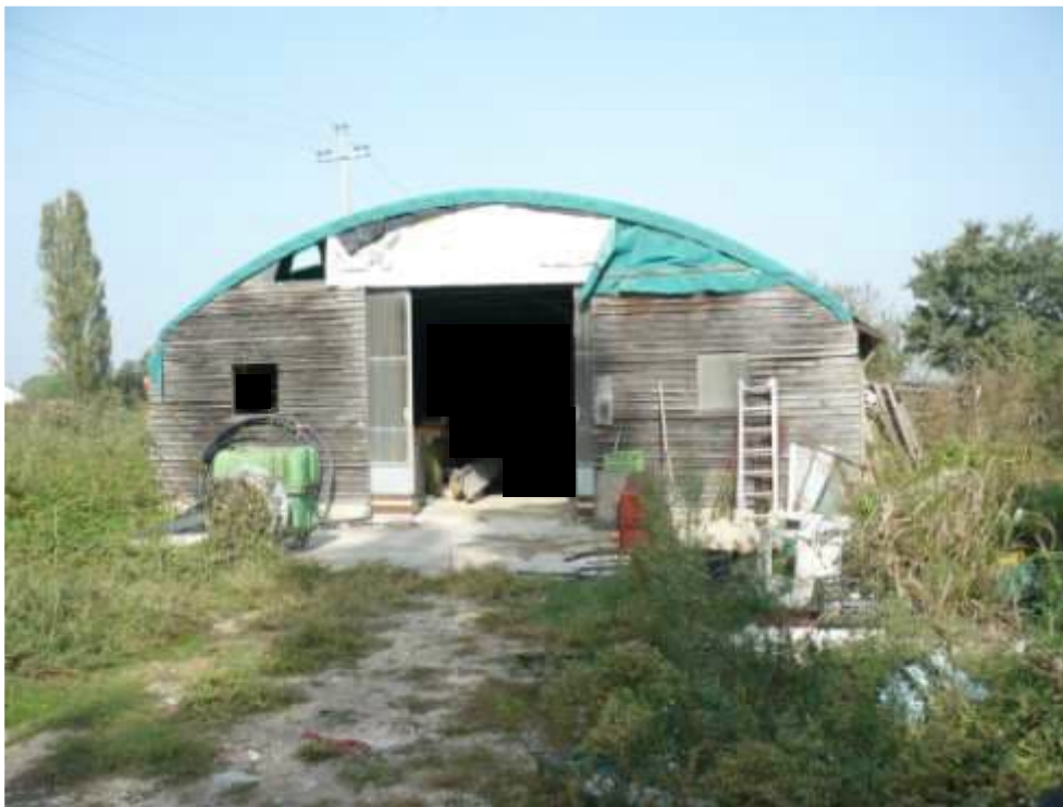
Locale uso Stalla/ricovero attrezzi in legno dimensioni ml 9,50 x ml 32,00 Pavimentazione in getto e copertura con struttura in ferro e teloni in pvc Opera abusivamente realizzata da demolire PROSPETTO SUD
