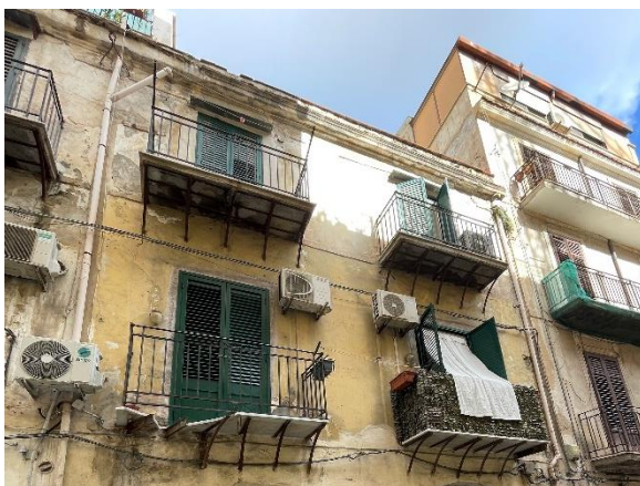
Balconi sulla via Sant'Isidoro
