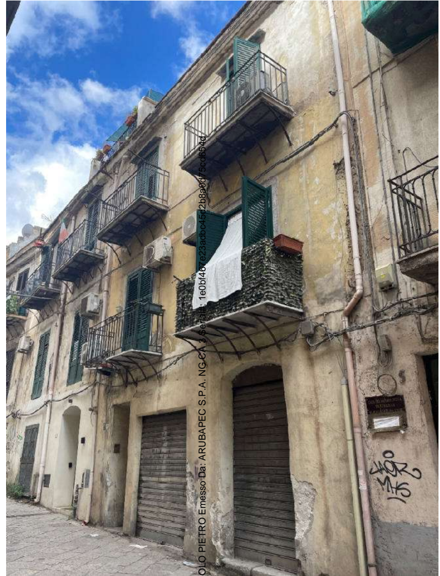
Foto n. 4 – Prospetto dell'edificio su via S. Isidoro alla Guilla
