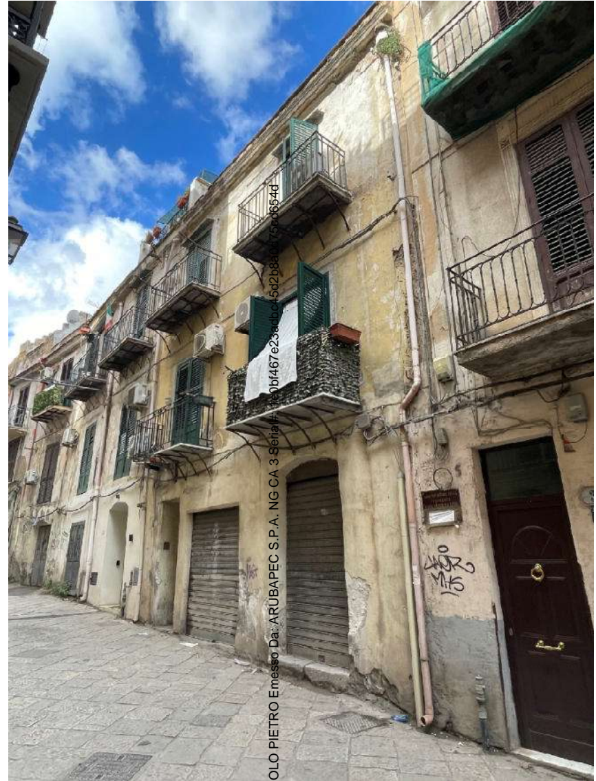
Foto n. 2 – Prospetto dell'edificio su via S. Isidoro alla Guilla
