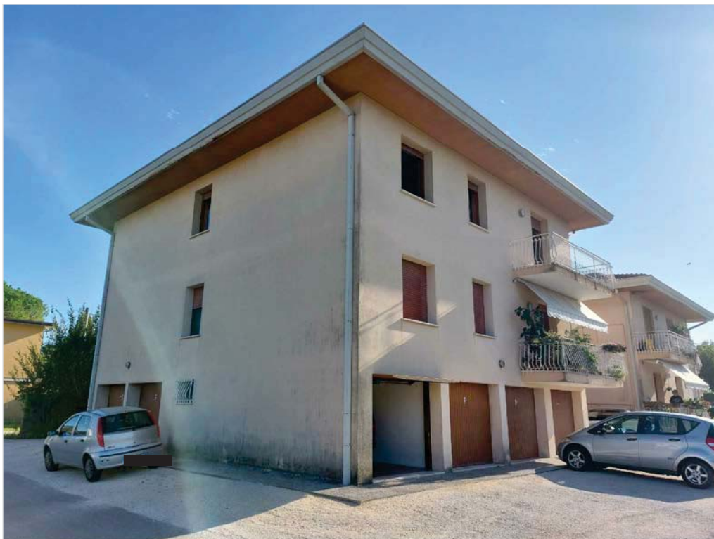
Foto n. 4: Prospetto nord-est del condominio "Riviera"
