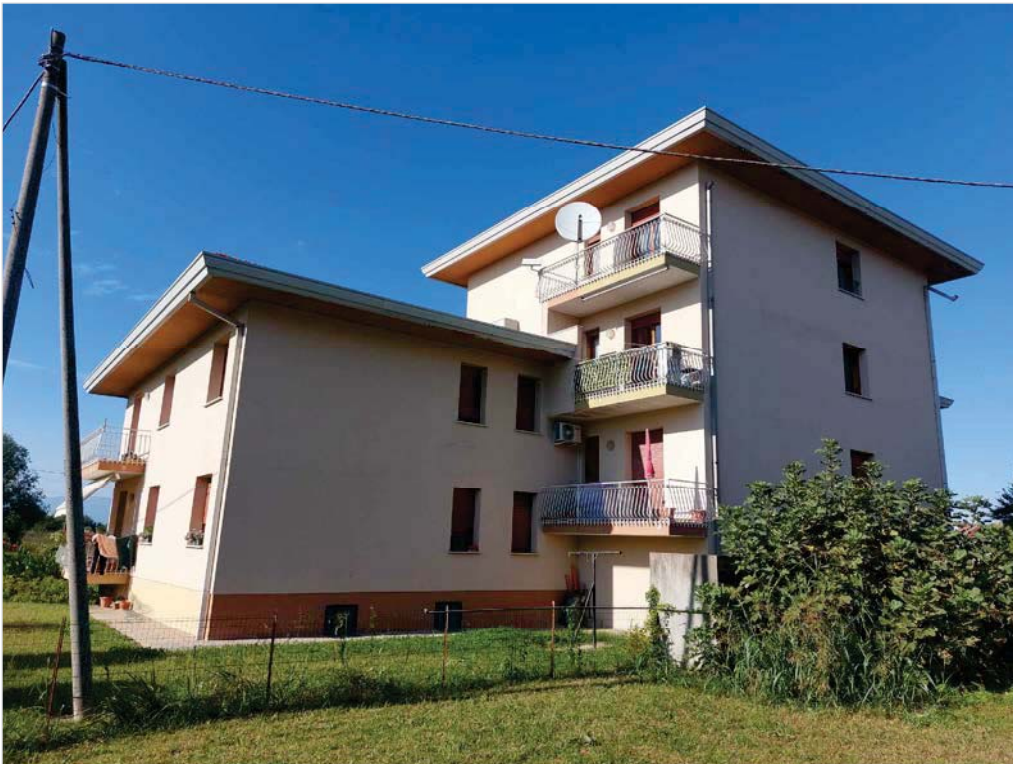
Foto n. 6: Prospetto sud-ovest del condominio "Riviera"
