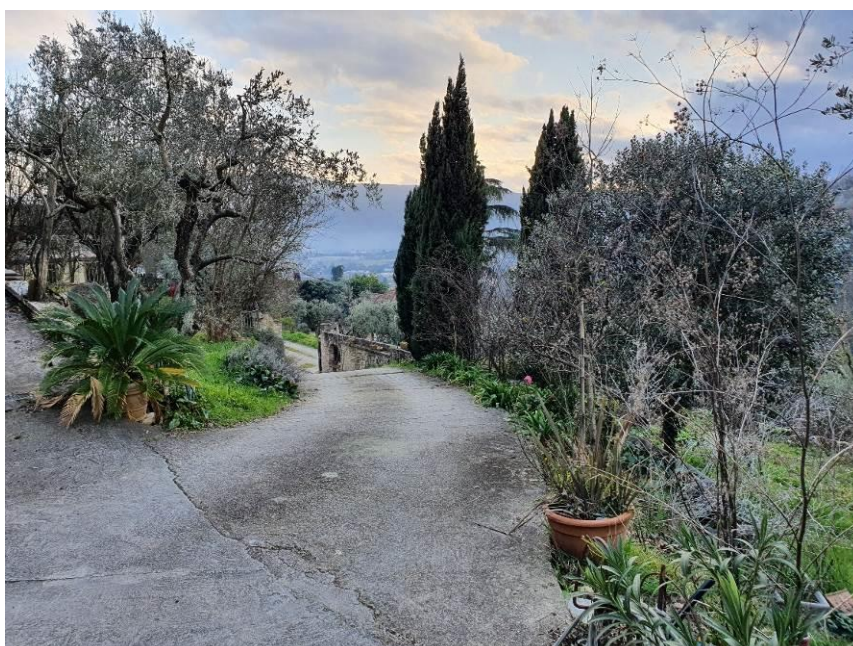
FOTO 4 (rampa e corte pavimentata)
