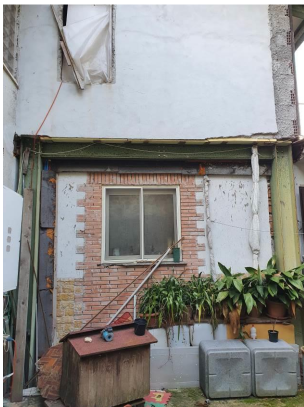
FOTO 7 (prospetto secondario, ampliamento da completare)
