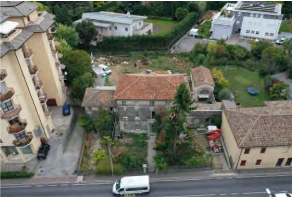
Figura 1 - VISTA AEREA FACCIATA PRINCIPALE (indagini strutturali e pulizia giardino in corso)
