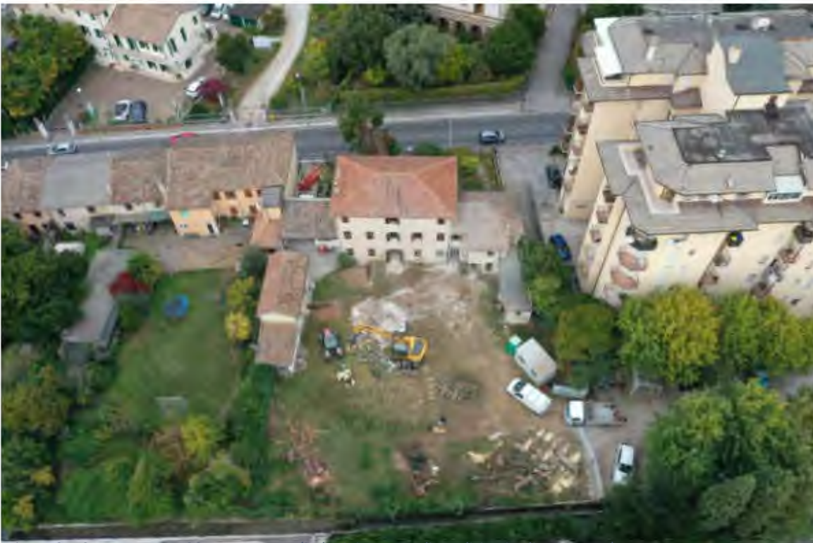
Figura 2 VISTA AEREA DA CORTE INTERNA (indagini strutturali e pulizia giardino in corso)
