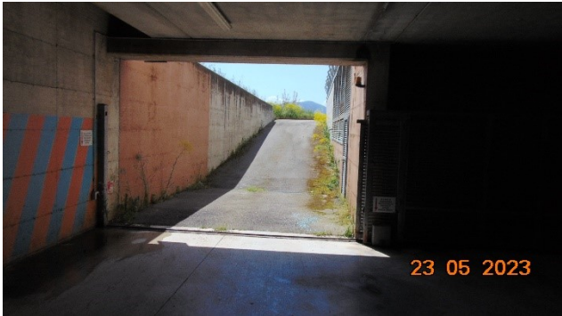
Foto n. 6 – Tunnel accesso garage
