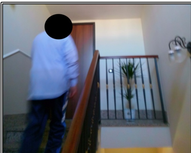
Figura 41 Vano scale e pianerottolo di accesso al secondo piano
