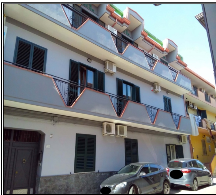
Figura 6 Facciata fabbricato su via Cadorna
