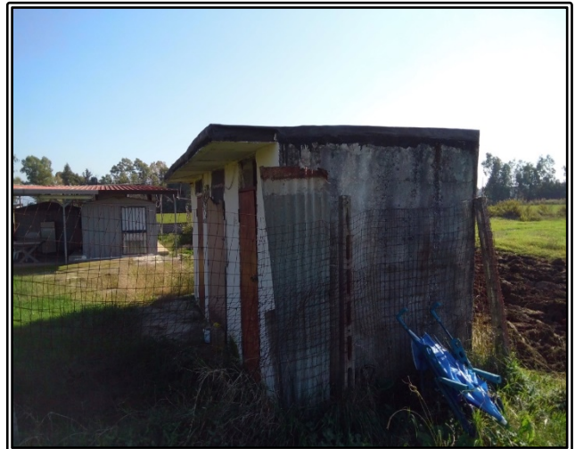
Figura 57 fabbricato in muratura
