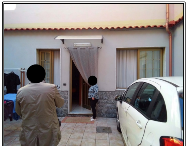
Figura 17 Ingresso seconda porzione del subalterno4
