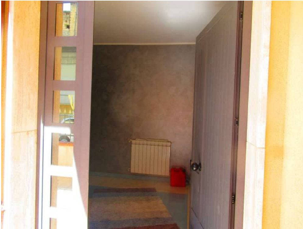
Foto n ° 83 – Porta d'ingresso al piano terra. –
