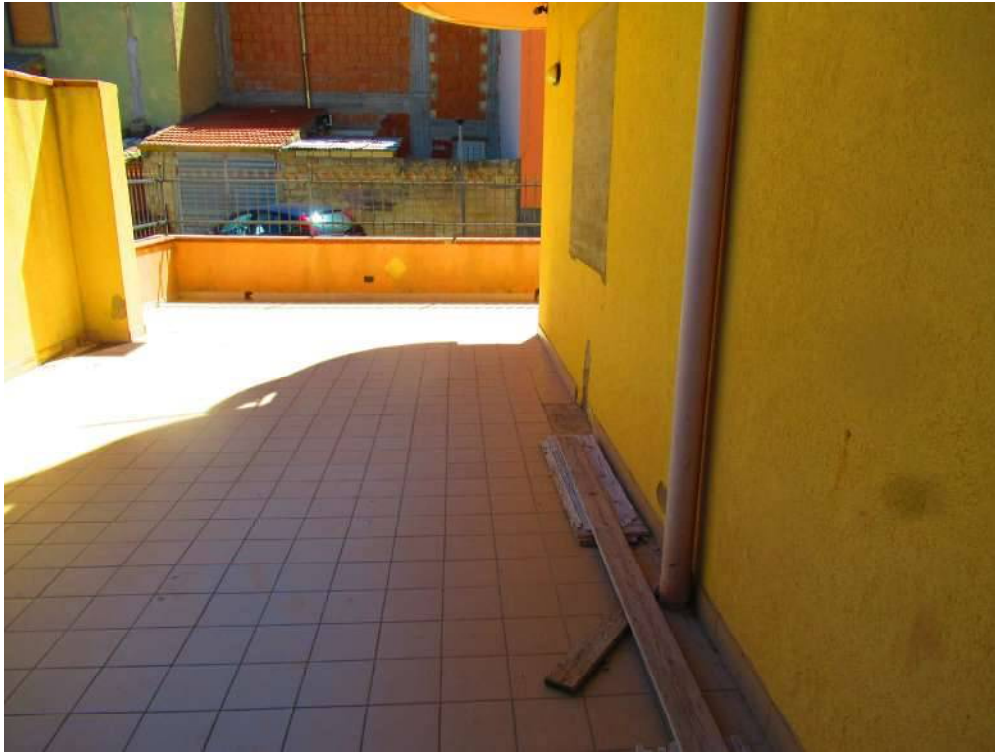
Foto n ° 109 – Spazio esterno – altra angolazione. –
