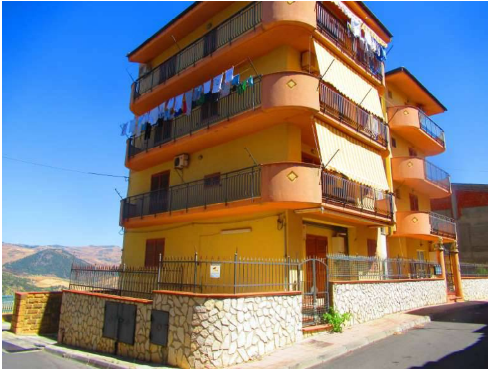
Foto n ° 7 – Vista generale di tutta la palazzina nella sua interezza e complessità . –
