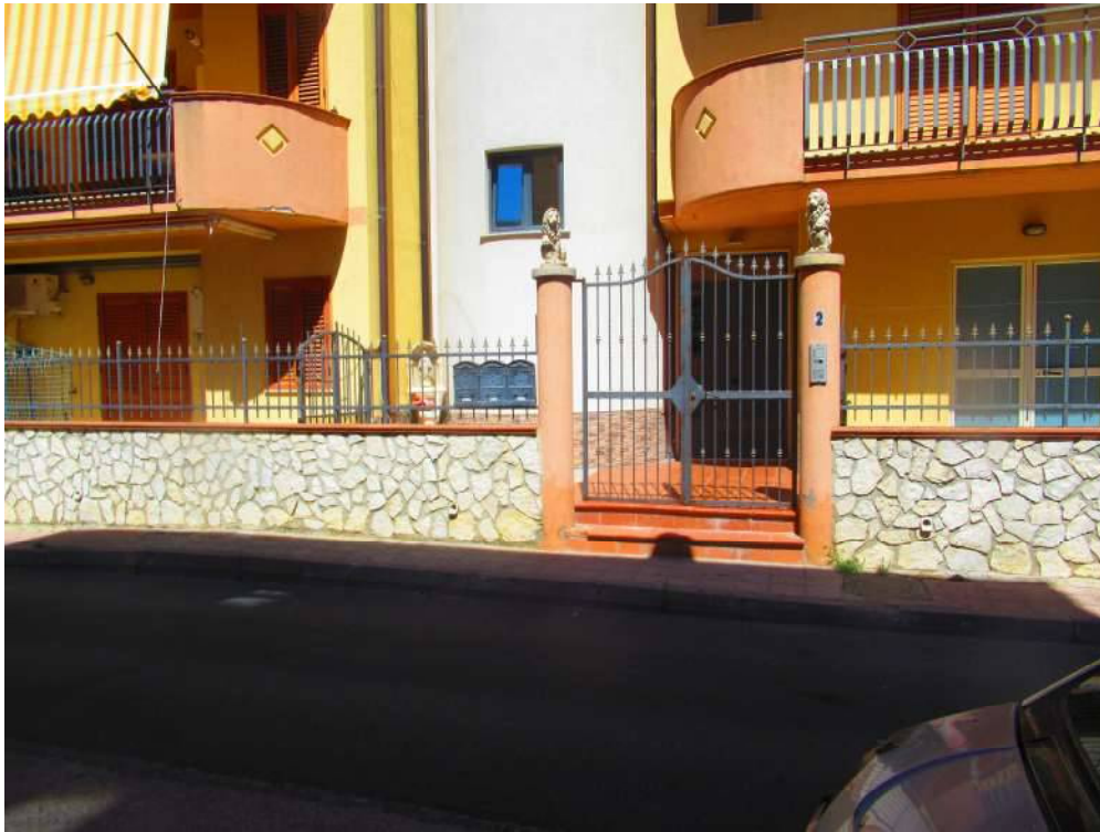
Foto n ° 3 – Vista dell'ingresso principale . –
