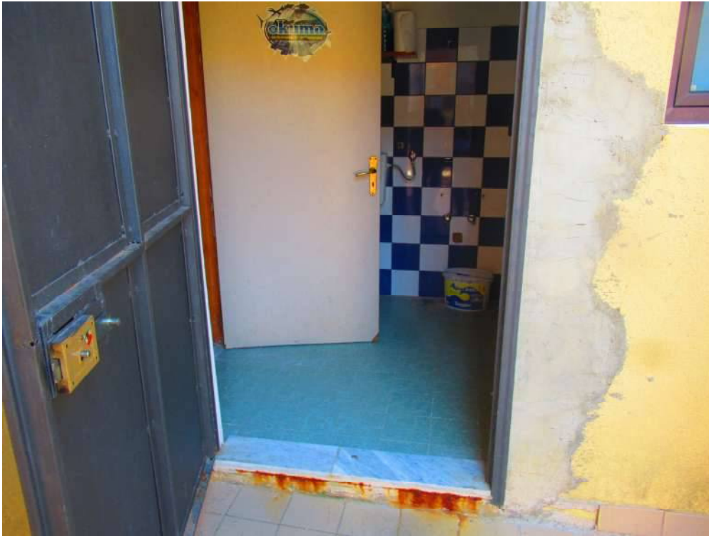
Foto n ° 119 – Ingresso sub 10. –
