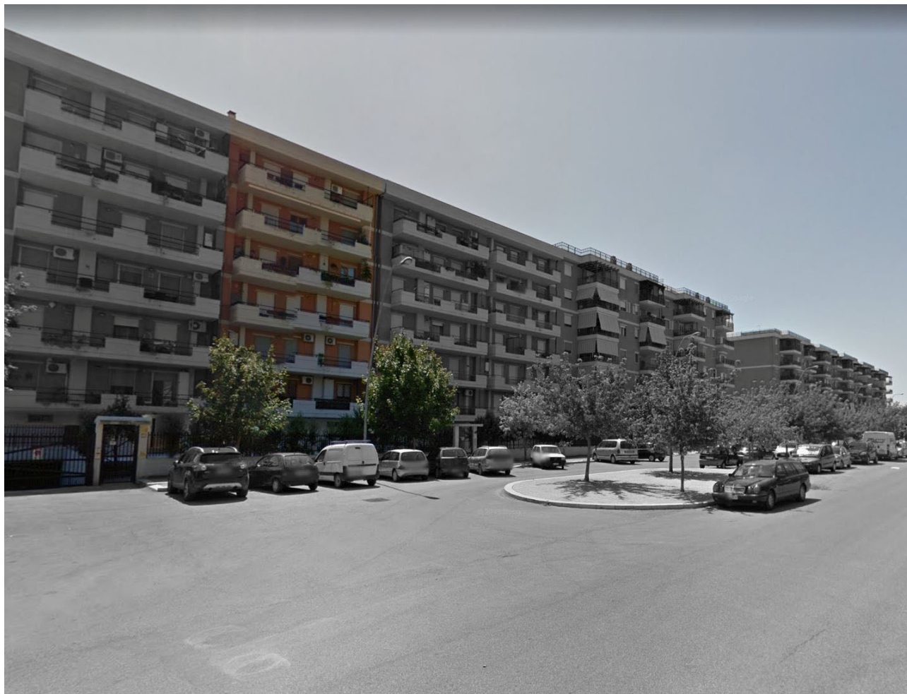
Figura n.3 (Individuazione ingresso del fabbricato)
