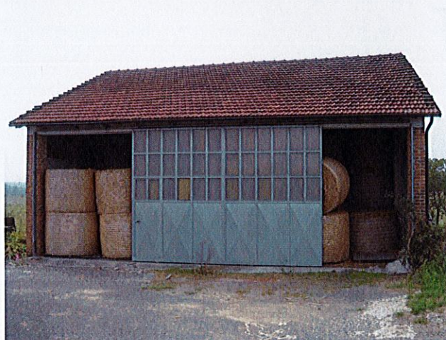
Tettoia antistante Cascina Cavallero Foglio 25 n.285 subb.2
