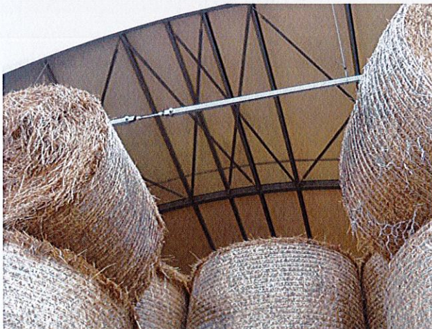
Nuova tettoia, dettaglio struttura metallica Foglio 25 n.314
