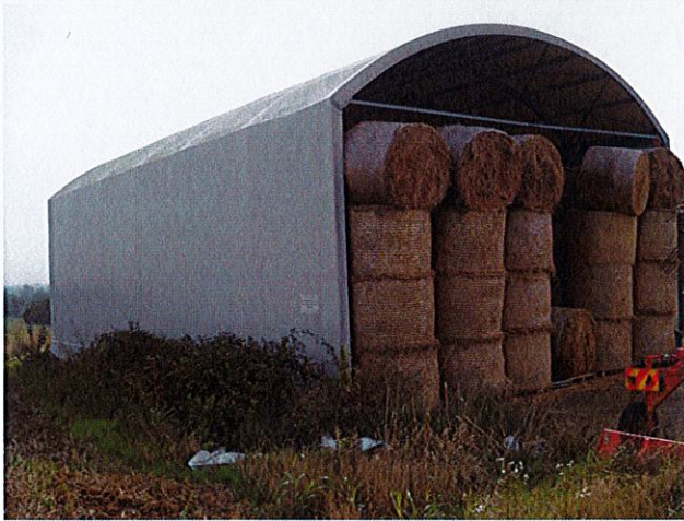
Nuova tettoia Foglio 25 n.314
