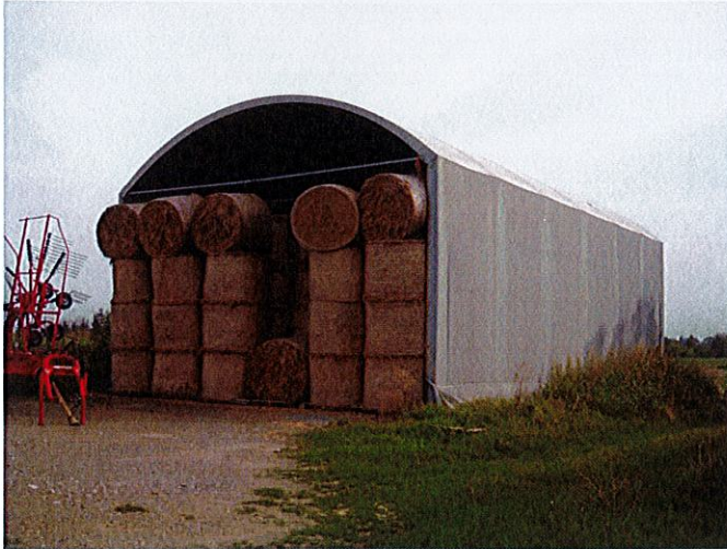
Nuova tettoia Foglio 25 n.314
