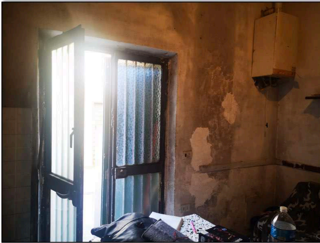
7. VISTA INGRESSO DALLA CUCINA
