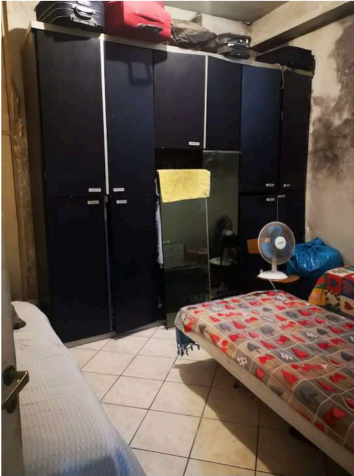
22. VANO 2 - VISTA DALLA PORTA
