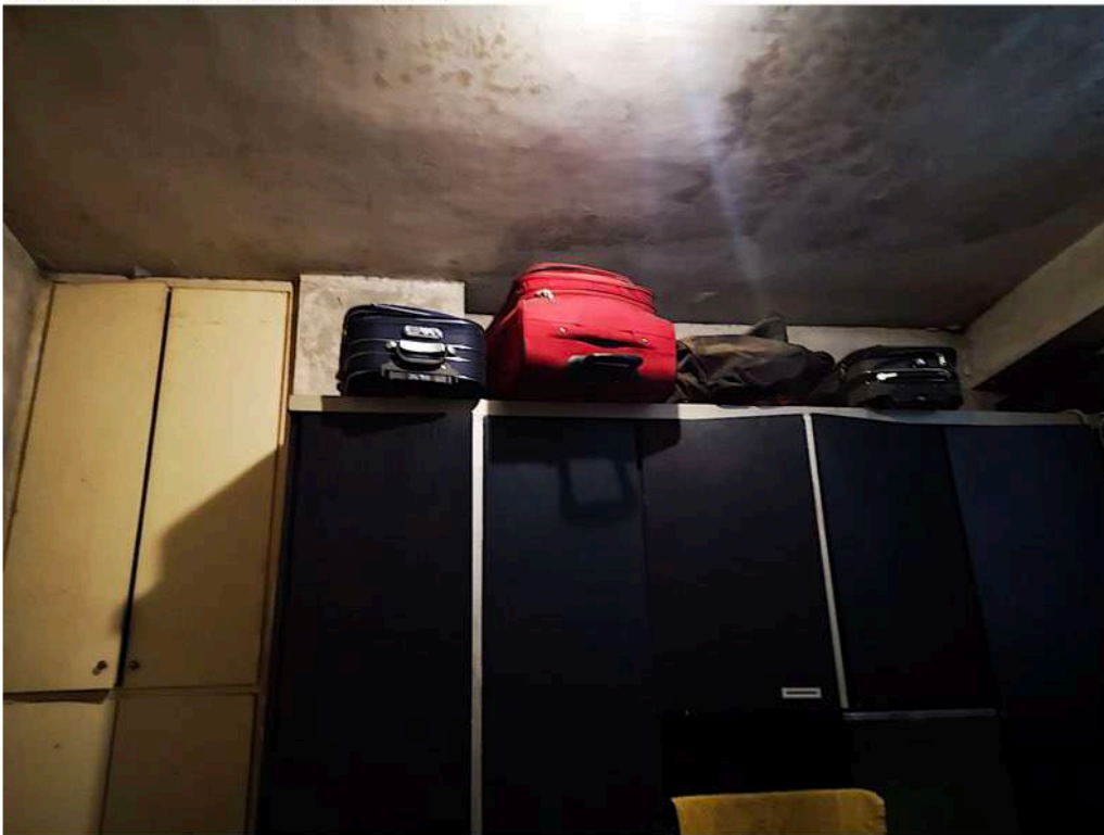
23. VANO 2 - VISTA DALLA PORTA
