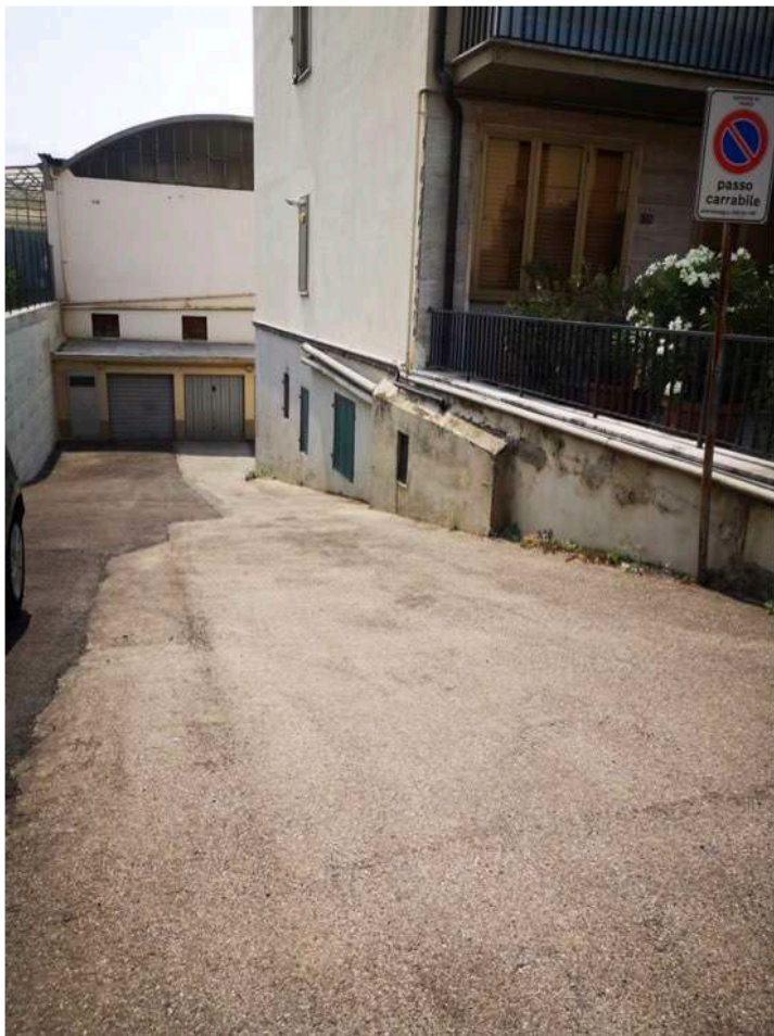
3. RAMPA DI ACCESSO ALL'INGRESSO DELL'APPARTAMENTO
