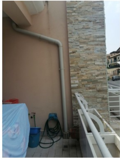
balcone con presa di acqua
