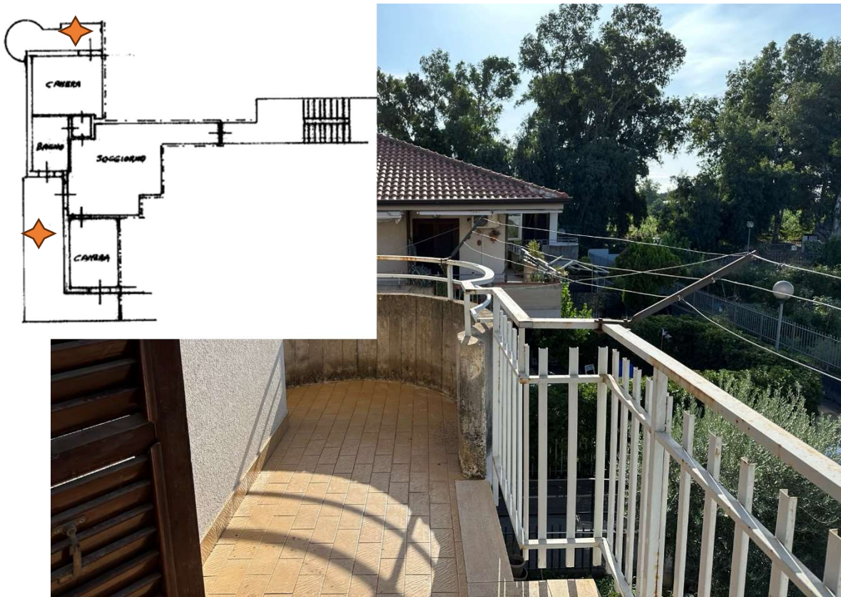
Foto 12_balcone lato sud
