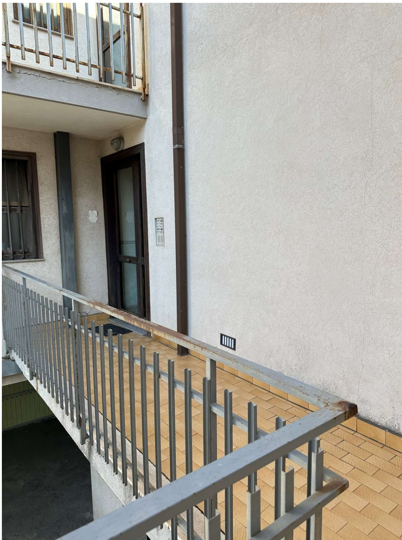
Foto 3_Ingresso piano terra lato sud
