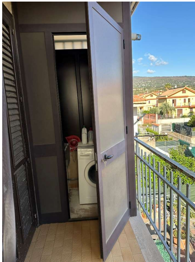
Foto 15_balcone lato nord
