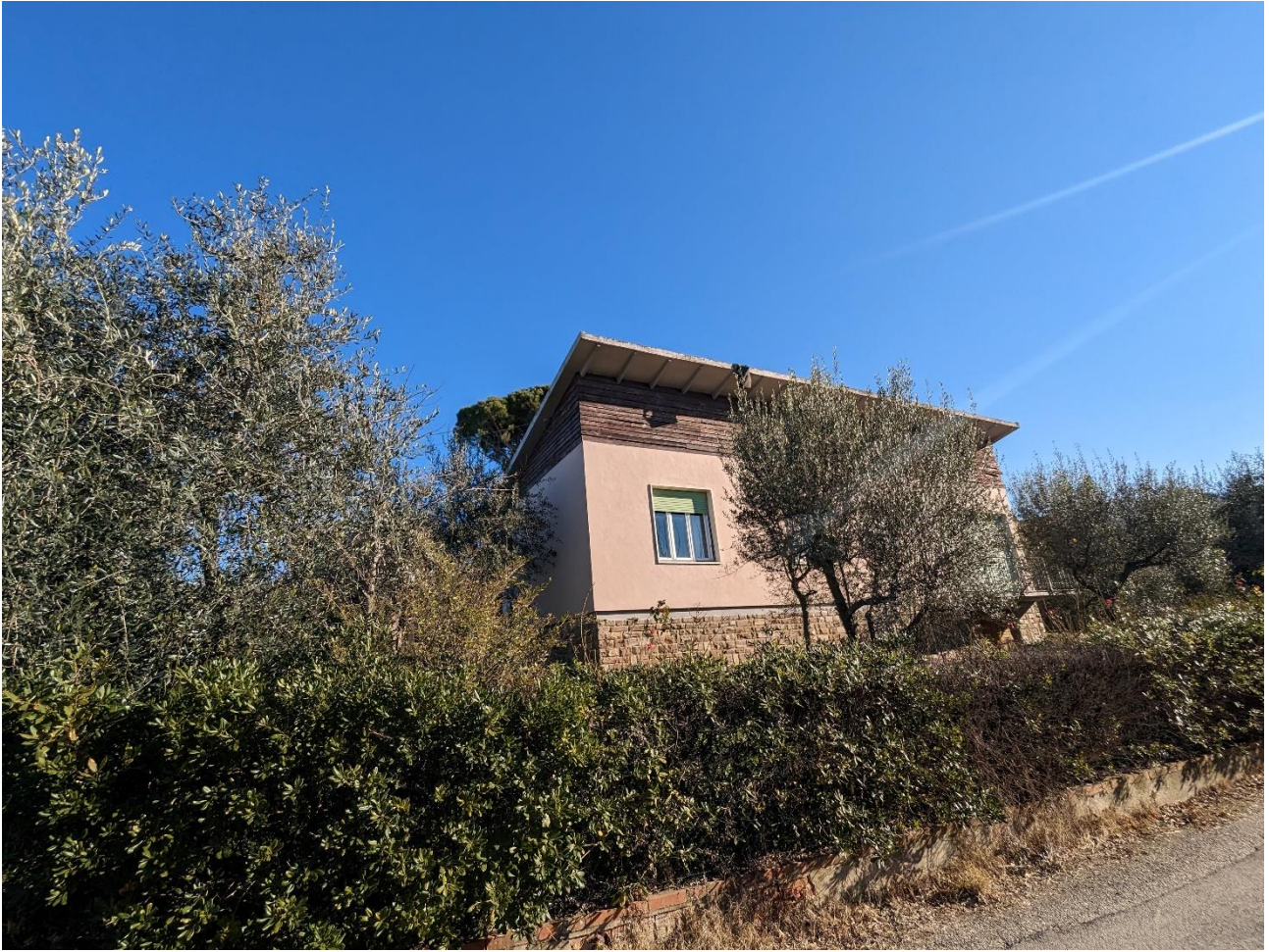
Figura 6 Vista lato sud
