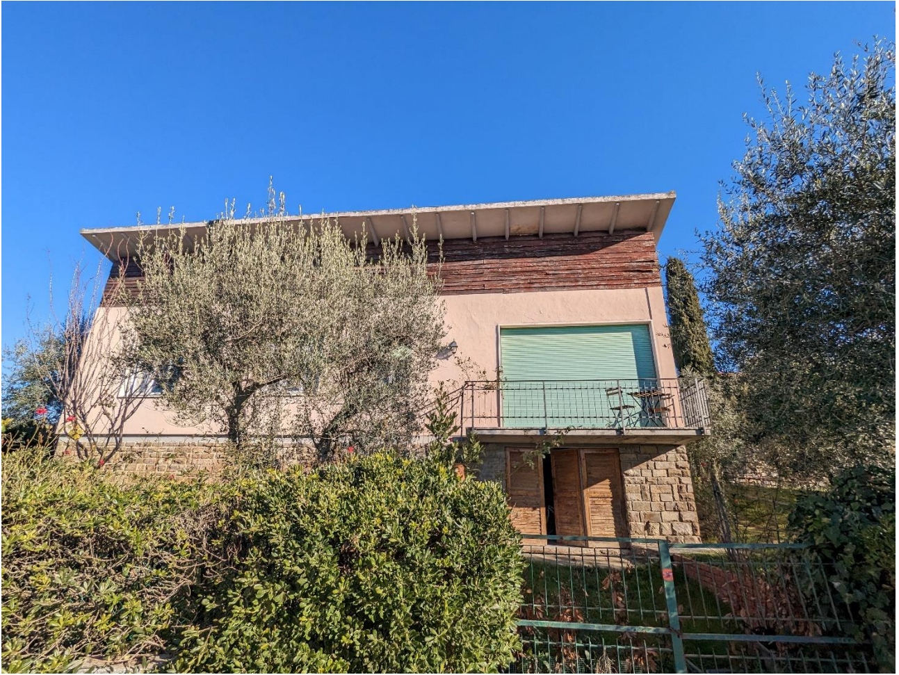
Figura 17 Vista lato sud con ingresso carrabile
