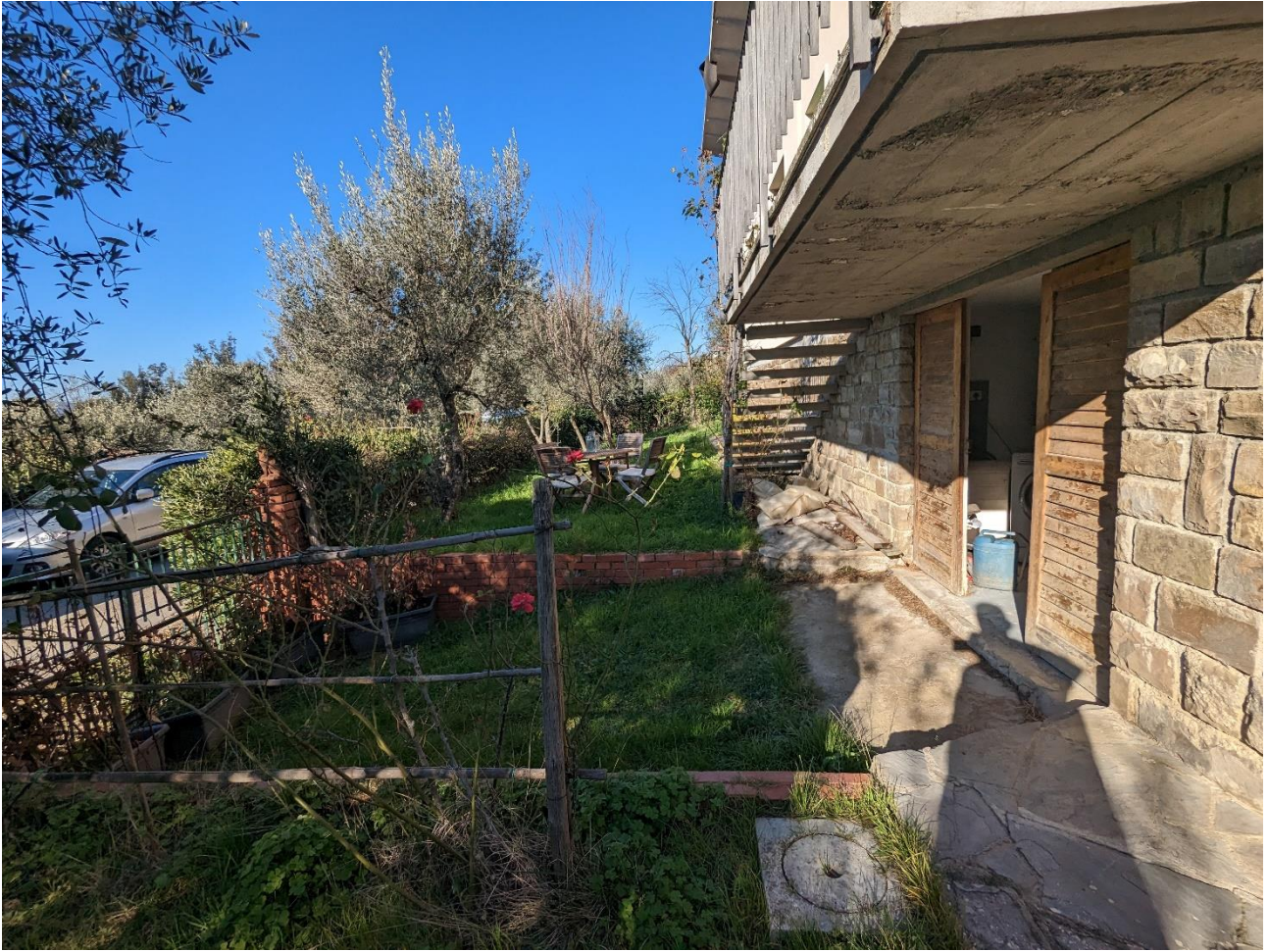
Figura 10 Vista acceso Autorimessa
