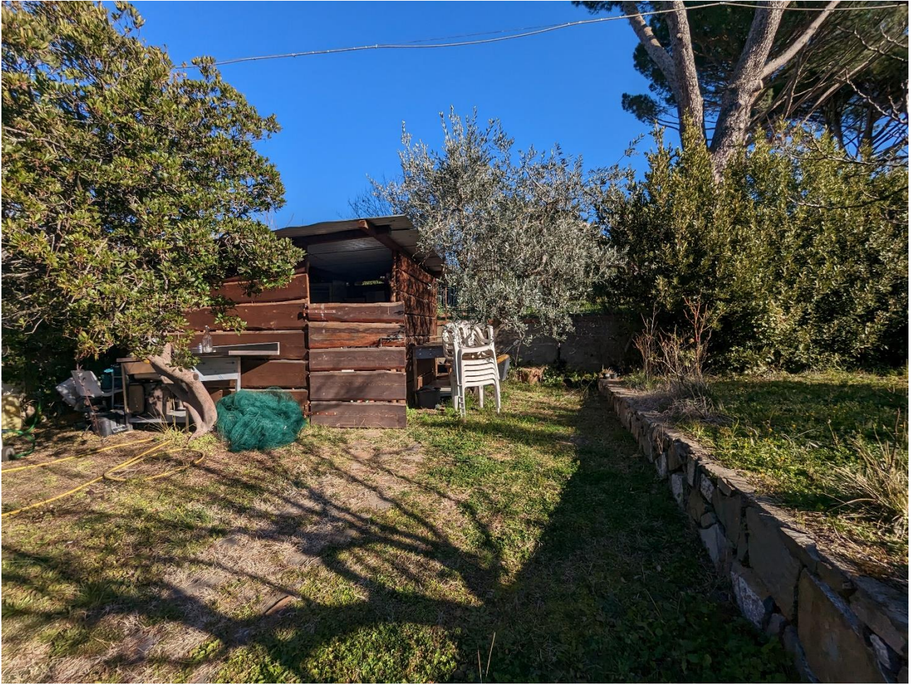
Figura 8 Vista resede con tettoia non regolare
