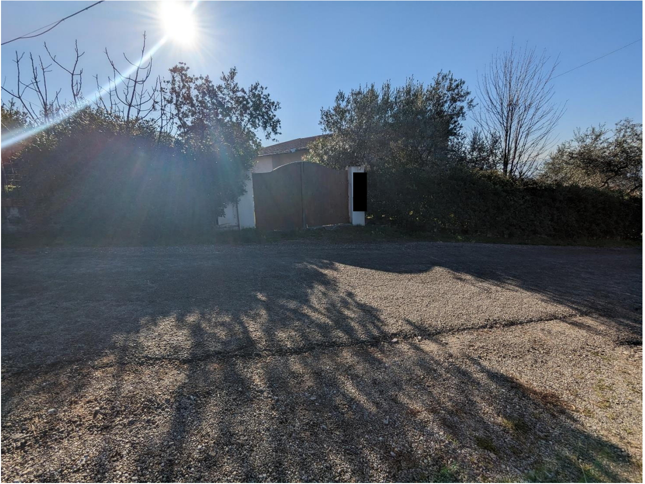
Figura 7 Vista accesso lato nord
