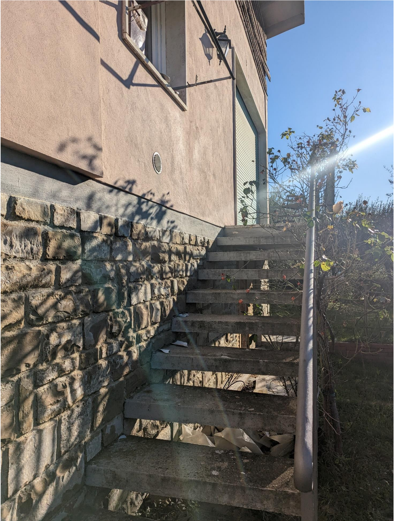
Figura 15 Scala accesso esterna verso Soggiorno
