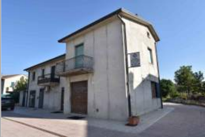
Fabbricato su cui insiste la particella 229 sub 3 vista generale
