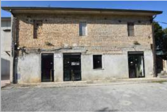
Fabbricato si cui insiste l'U.I. foglio 142 particella 110 sub. 13
