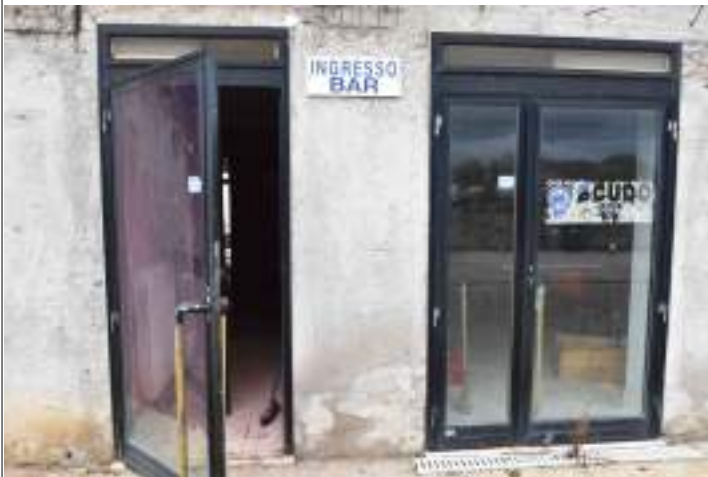
Ingresso posteriore U.I. foglio 142 particella 110 sub. 13
