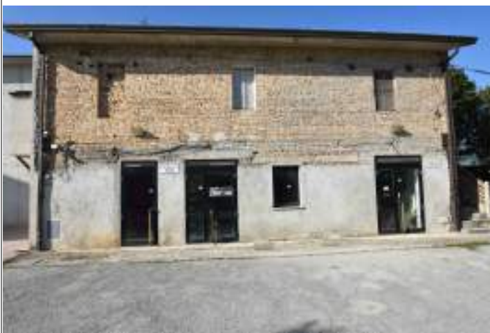
Fabbricato su cui insiste l'U.I. foglio 142 particella 110 sub. 8 - prospetto retro con ingresso su corte interna
