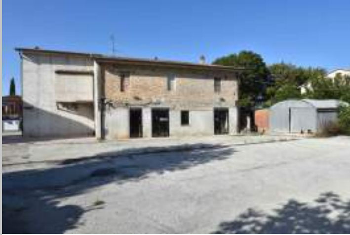
Fabbricato su cui insistono le unità immobiliari oggetto di stima
