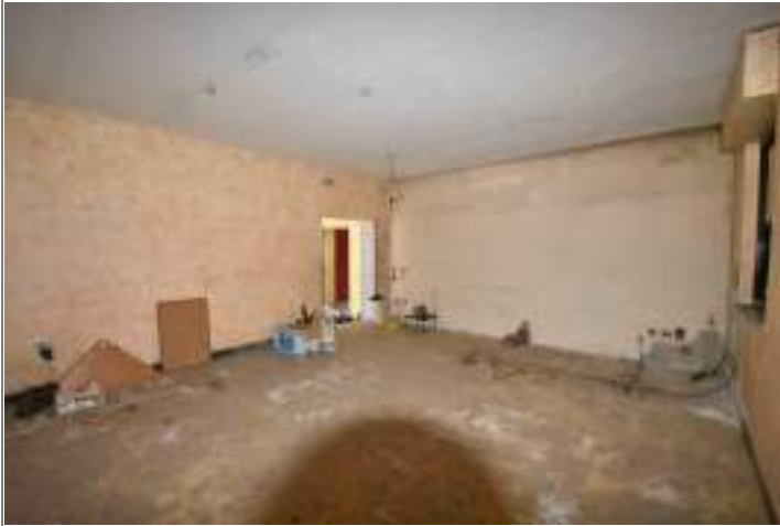
U.I. foglio 142 particella 229 sub 3 - piano terra - unico vano
