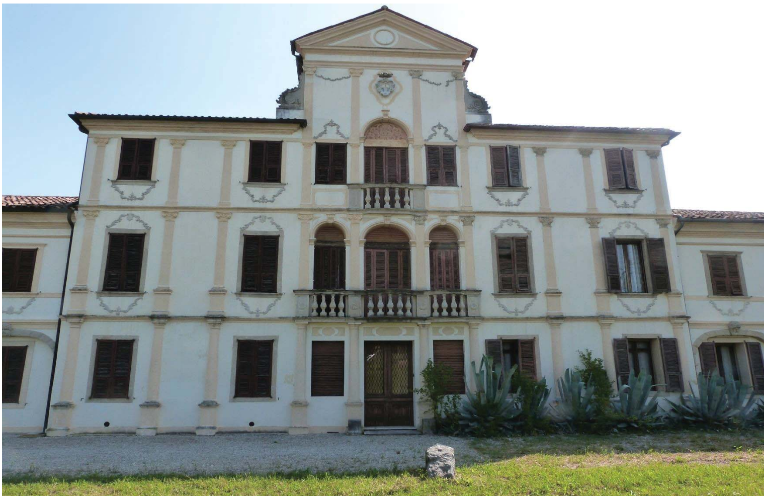
Vista del corpo centrale – prospetto principale.
