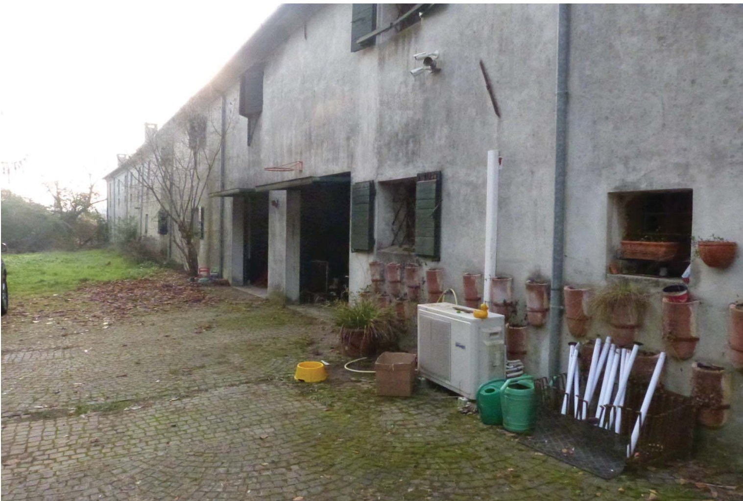
Area scoperta con piscina dismessa.
