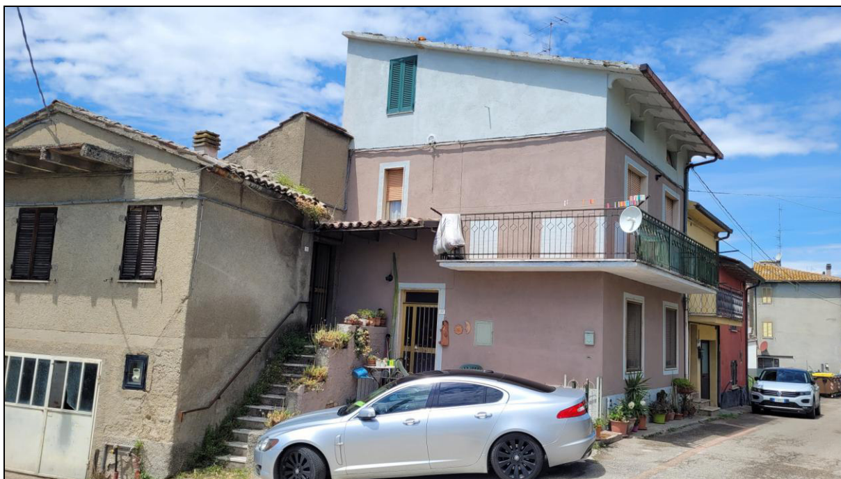
Foto 2: vista fabbricato lato nord-est
