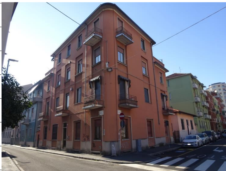
Vista esterna del complesso
