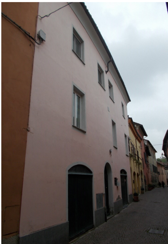
2. Accesso al fabbricato da Via Cavanna civico n. 19
