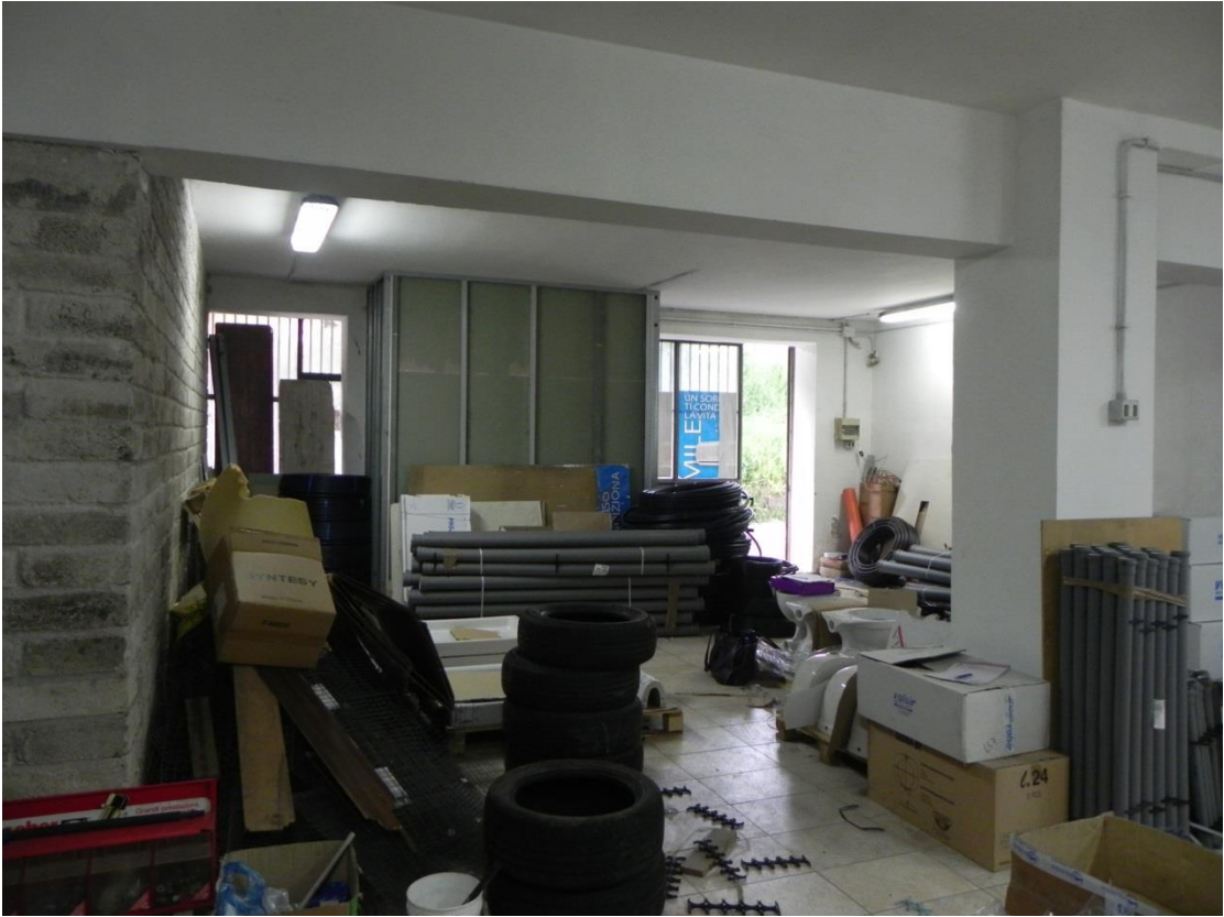
LOCALE AUTORIMESSA PIANO S1 ADIBITO A MAGAZZINO
