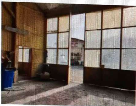
Fig. 33. Interno fabbricato abusivo - locale lavorazione 2
