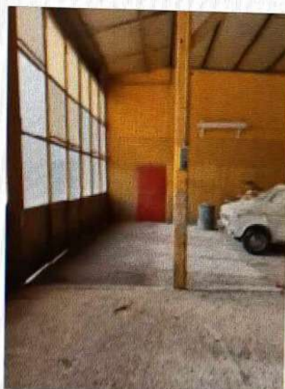
Fig. 28. Interno fabbricato abusivo - locale lavorazione 1
