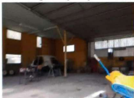
Fig. 31. Interno fabbricato abusivo - locale lavorazione 2
