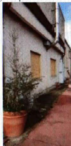
Fig. 5. Esterno opificio – lato est
