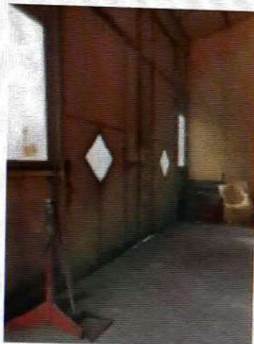
Fig. 34. Interno fabbricato abusivo - locale lavorazione 2
