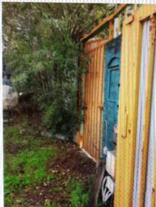
Fig. 39. Ingresso pedonale – vista interna
