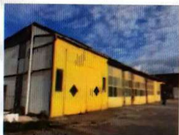
Fig. 24. Esterno fabbricato abusivo – vista ovest
