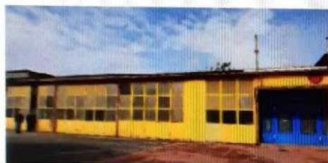
Fig. 23. Esterno fabbricato abusivo – vista sud
