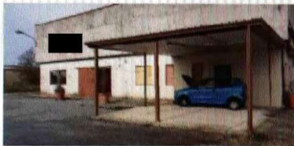
Fig. 2. Esterno opificio – Lato sud – est Ingresso anteriore
