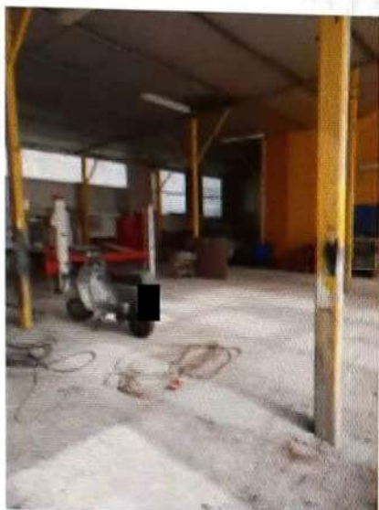
Fig. 27. Interno fabbricato abusivo - locale lavorazione 1
