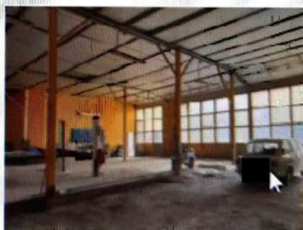
Fig. 26. Interno fabbricato abusivo - locale lavorazione I
