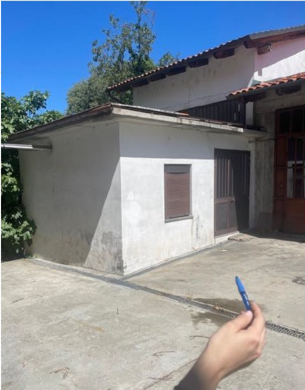
Fig. 1 Accesso ad Autorimessa da Cortile Retro di Via Santa Lucia n. 18
