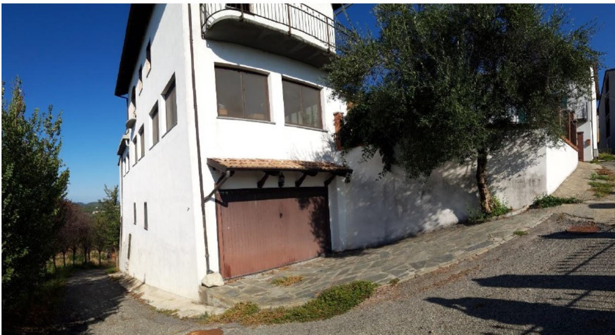
Fig. 2 Vista Prospetto EST del Piano terra.
