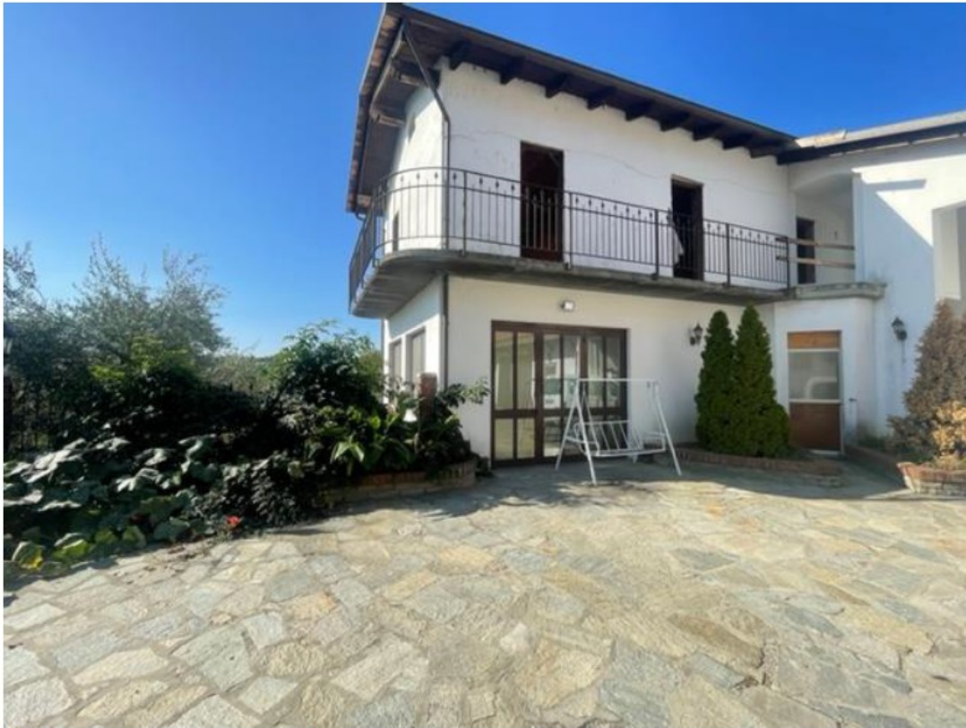
Fig. 1 Accesso a Locale Sgombero dal Cortile.
