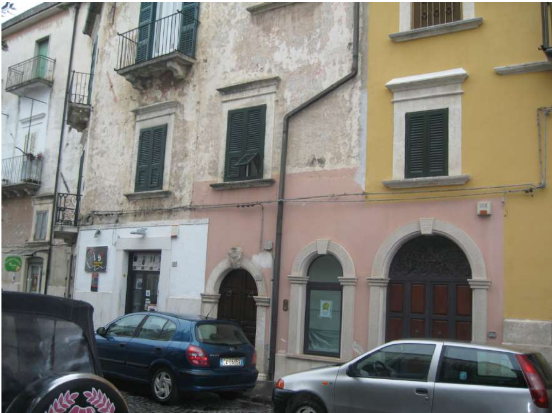
Foto n.4: vista generale dello stabile ove è ubicato il lotto
