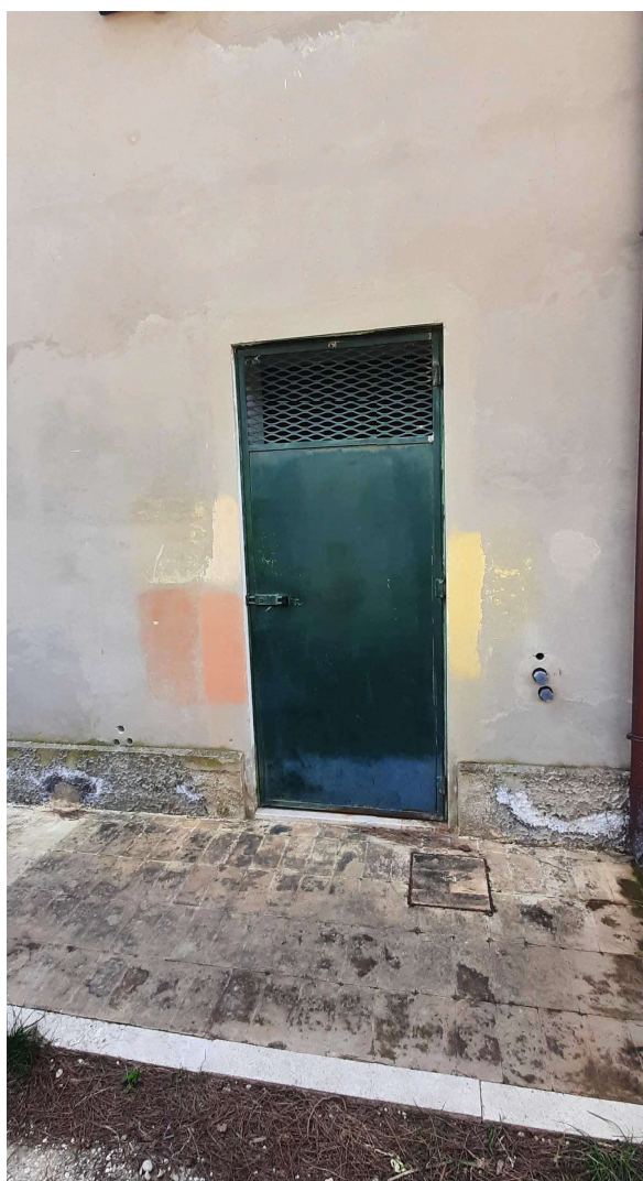
Foto 3 – Fabbricato esterno, porta centrale termica (Bene comune non censibile) al piano terra del fabbricato
