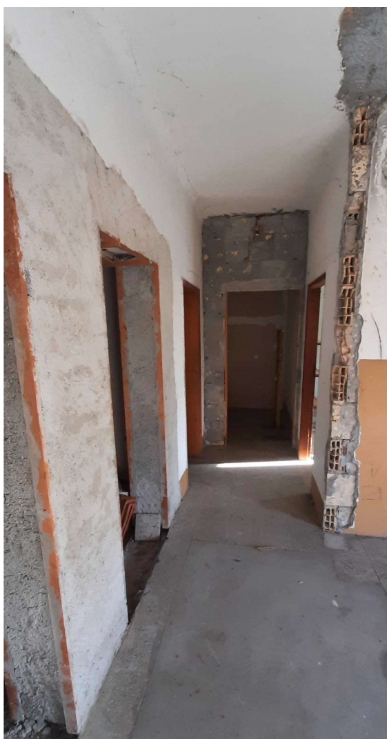
Foto 7 – U.i.u. Interno – sala d'ingresso
