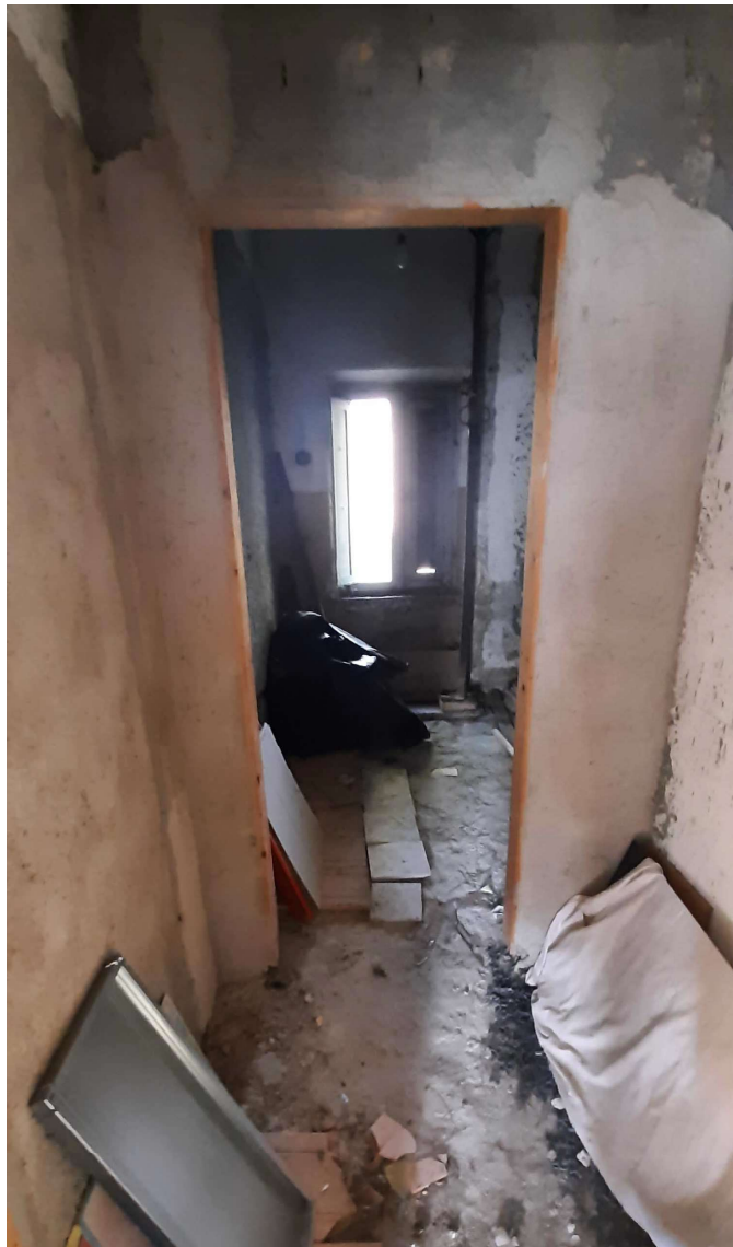
Foto 9 – U.i.u. Interno – locale nord
