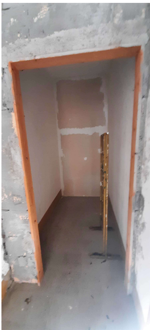
Foto 12 – U.i.u. Interno – locale disimpegno
