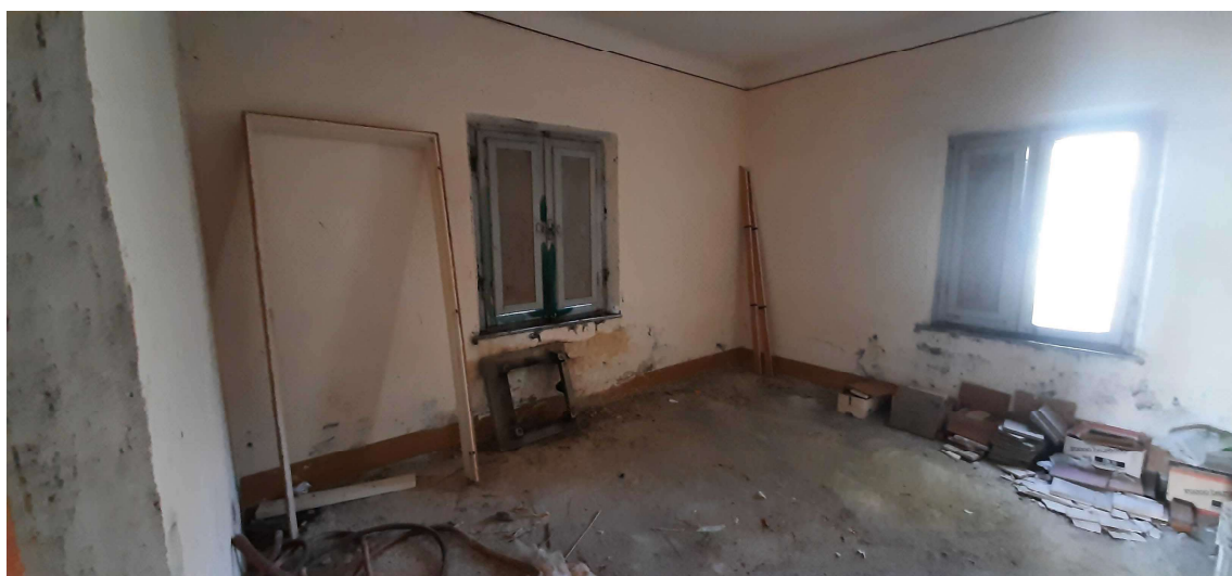
Foto 8 – U.i.u. Interno – locale nord ovest
