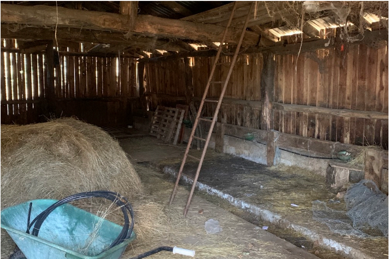
FOTO 3 _fabbricato- stalla- part. 527. Interno
