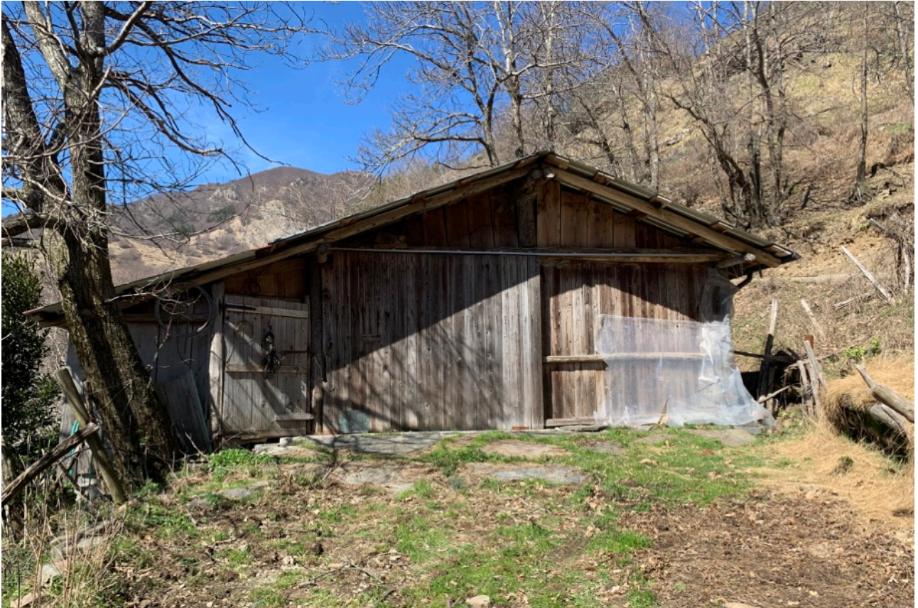
FOTO 1 _fabbricato- stalla- part. 527
