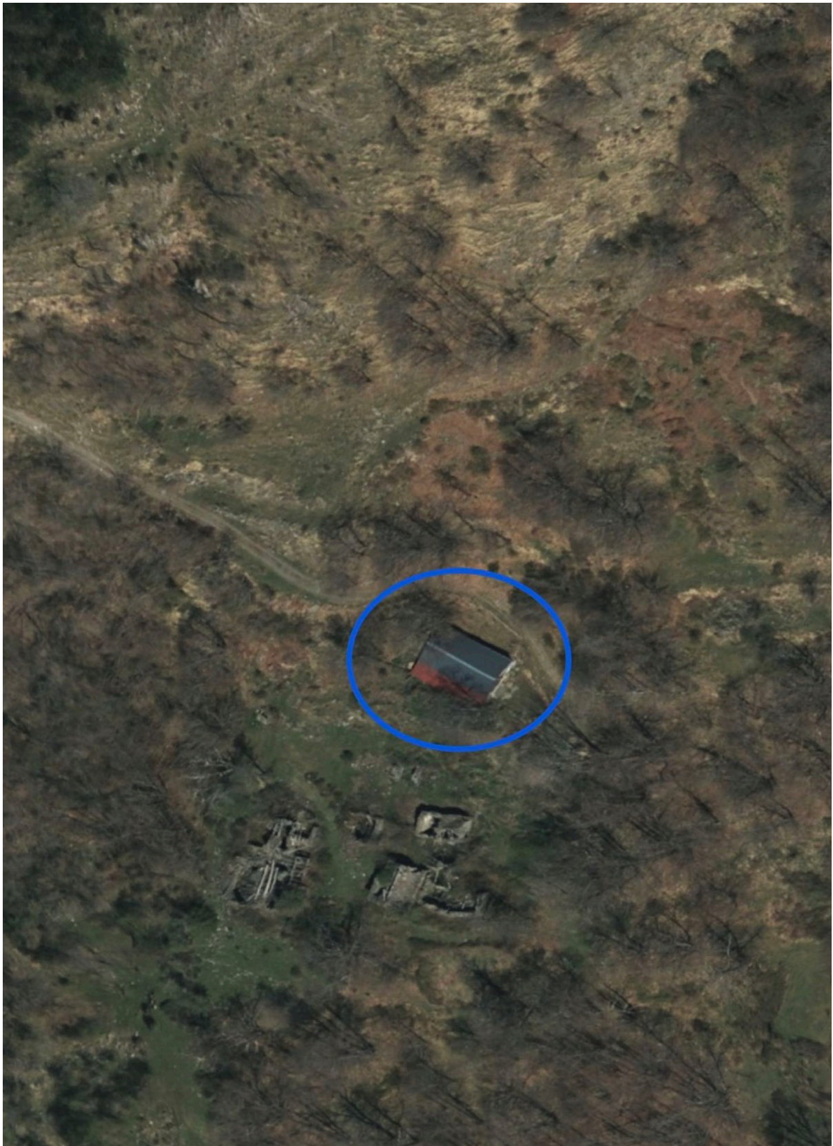
FOTO AEREA 3 _ dettaglio Fabbricato stalla Part. 527 (evidenziato in blu)
