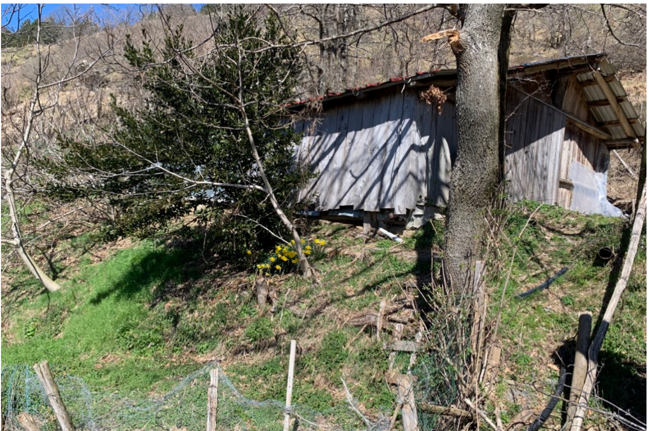
FOTO 2 _fabbricato- stalla- part. 527
