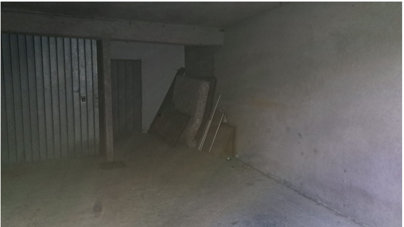
Vedute del garage al piano seminterrato – sub 19
