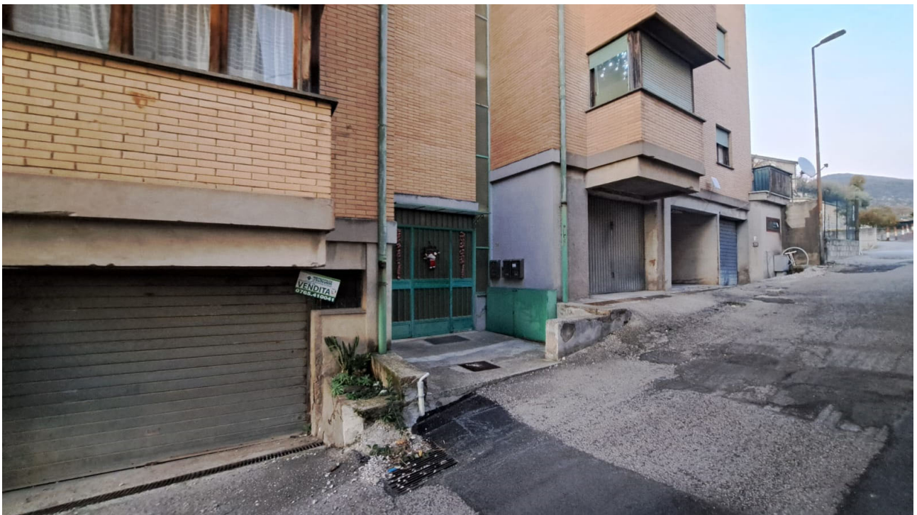
Vedute esterne del fabbricato e delle aree di accesso in via Ecole Nardi
