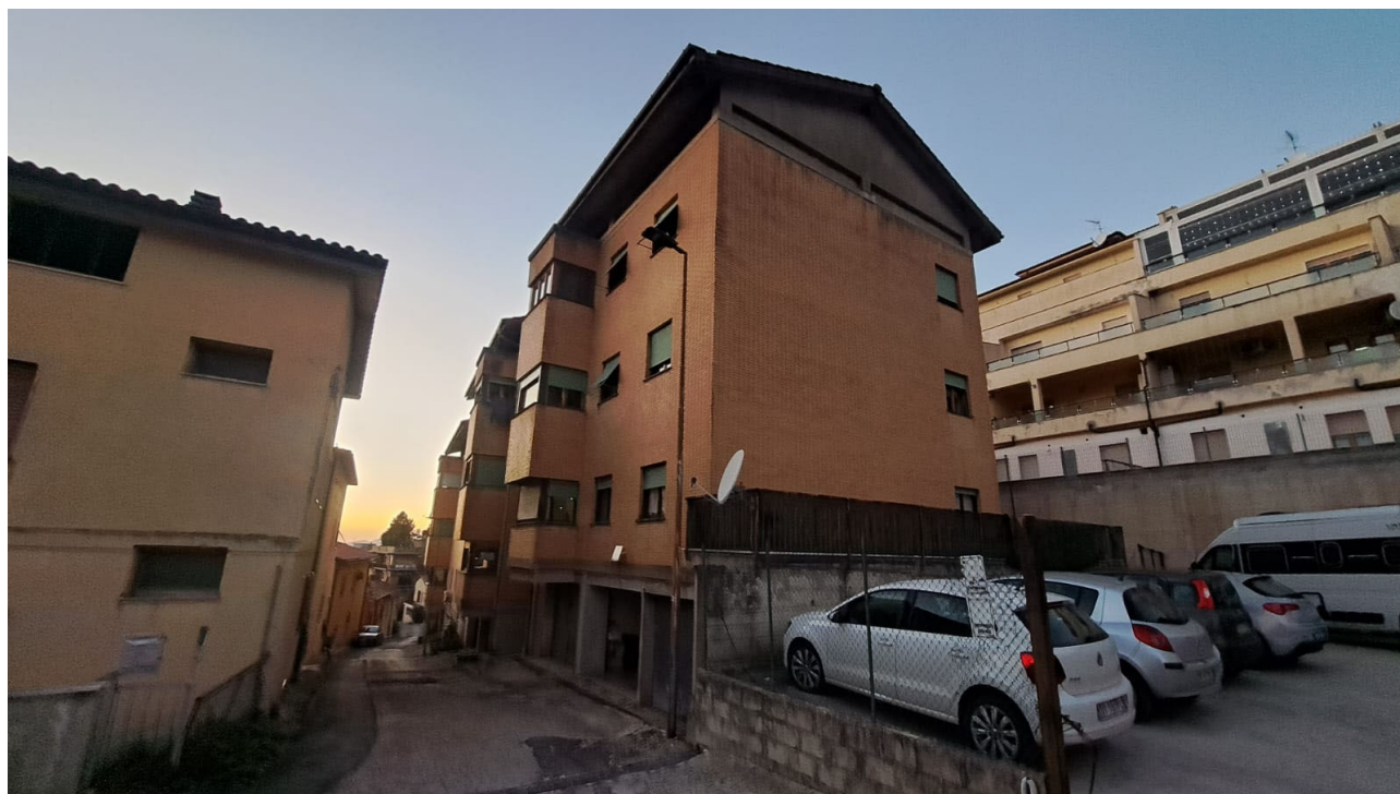
Vedute esterne del fabbricato e delle aree di accesso in via Ecole Nardi
