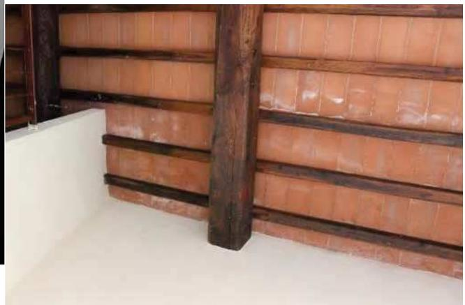
*Figura 19: Infiltrazioni nella copertura della camera*
