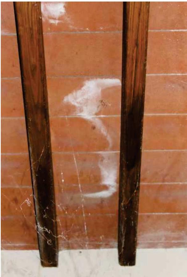
*Figura 11: Infiltrazioni nel solaio*
