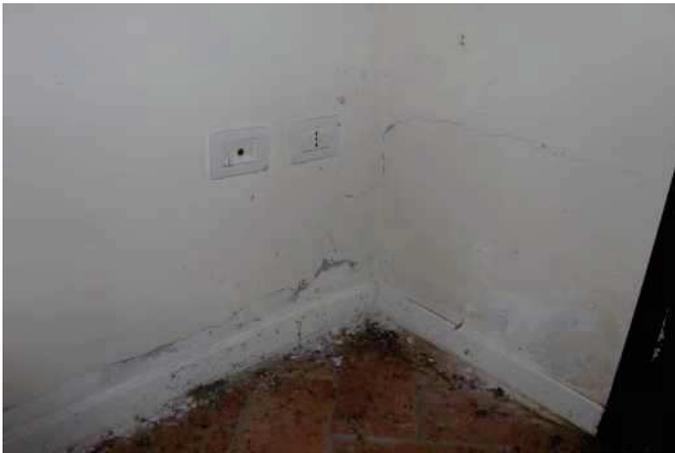
*Figura 18: Infiltrazioni nell'ango esterno posteriore*
