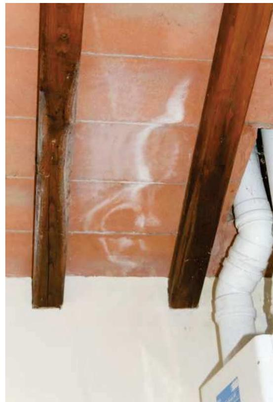
*Figura 16: Macchie di infiltrazioni nella copertura*
