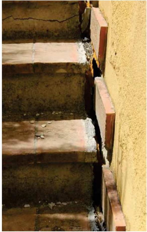
*Figura 20: particolare del distacco della rampa*
