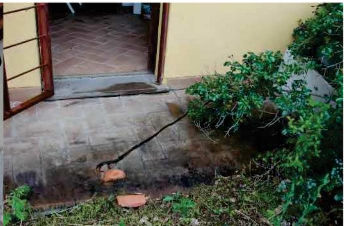
*Figura 18: Ammaloramento della pavimentazione del marciapiede*
