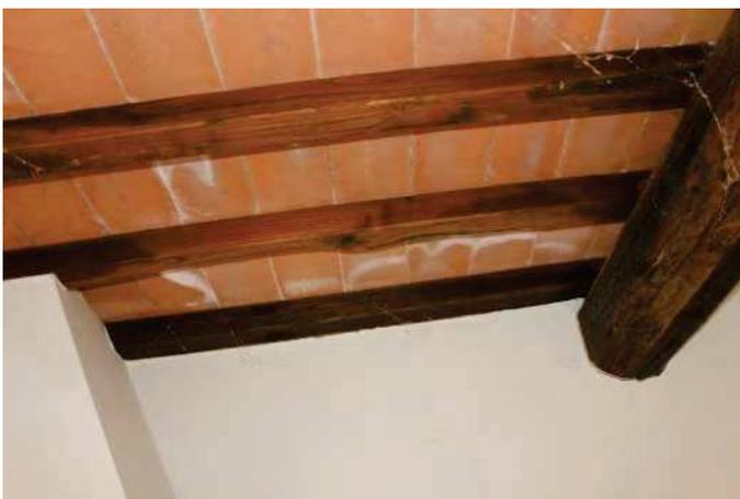
*Figura 15: Infiltrazioni nel solaio di copertura del soppalco*
