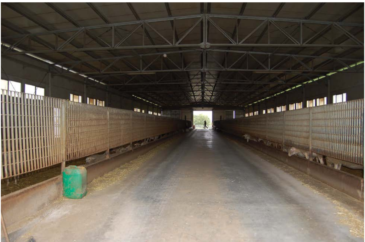
Foto 31 - Interno capannone prefabbricato adibito a stalla
