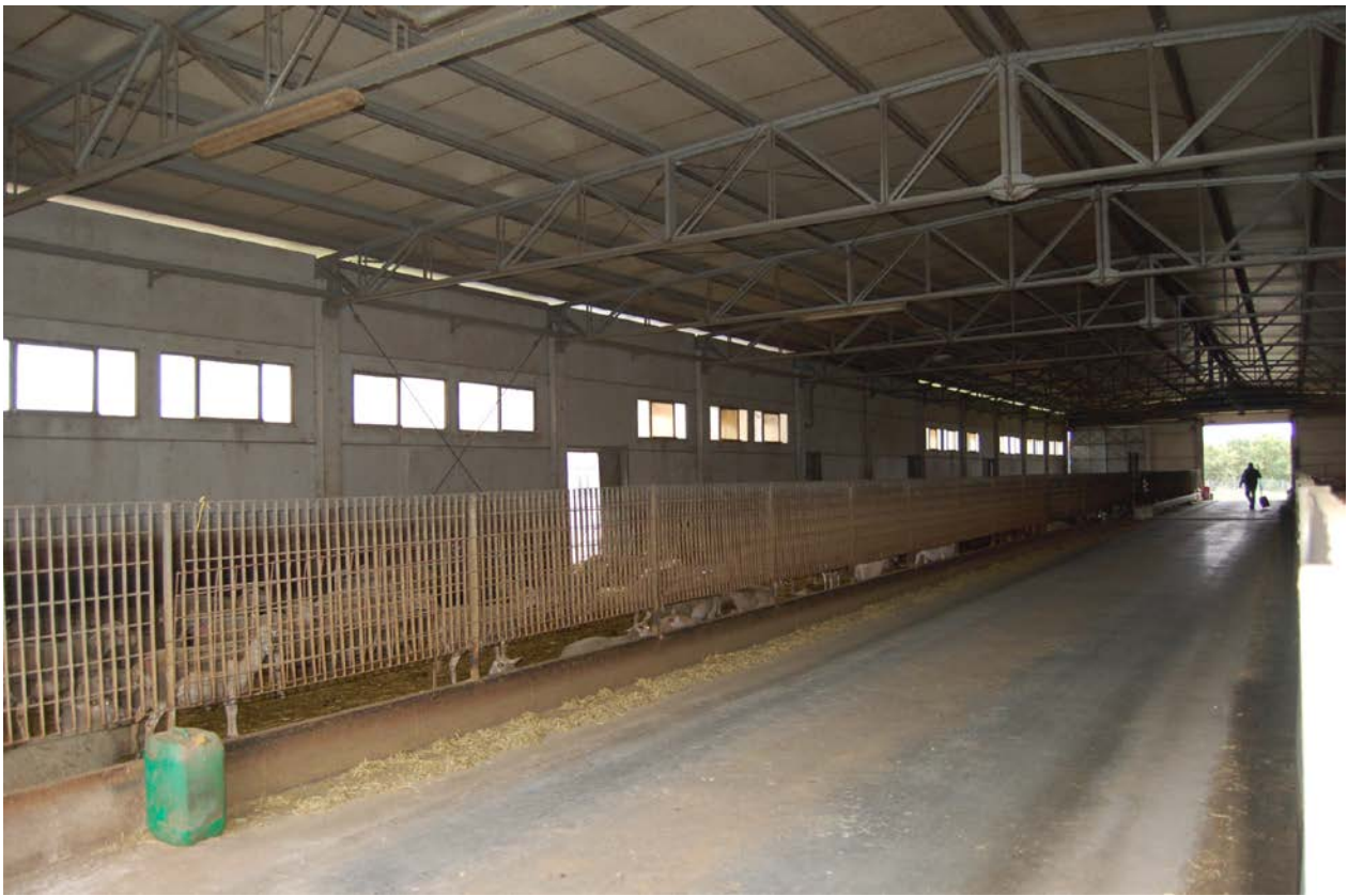
Foto 30 – Interno capannone prefabbricato adibito a stalla
