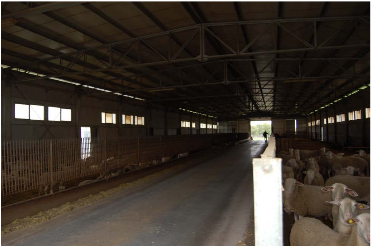
Foto 29 – Interno capannone prefabbricato adibito a stalla
