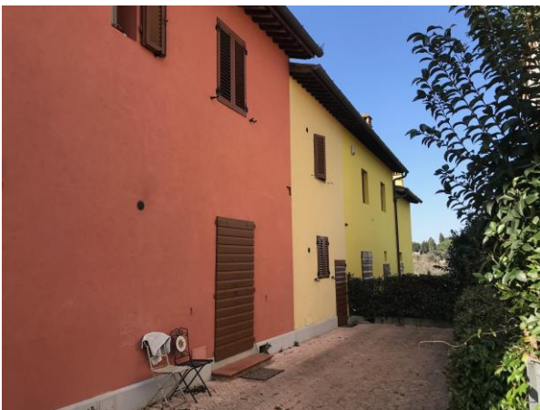
3- l'edificio lato di destra
