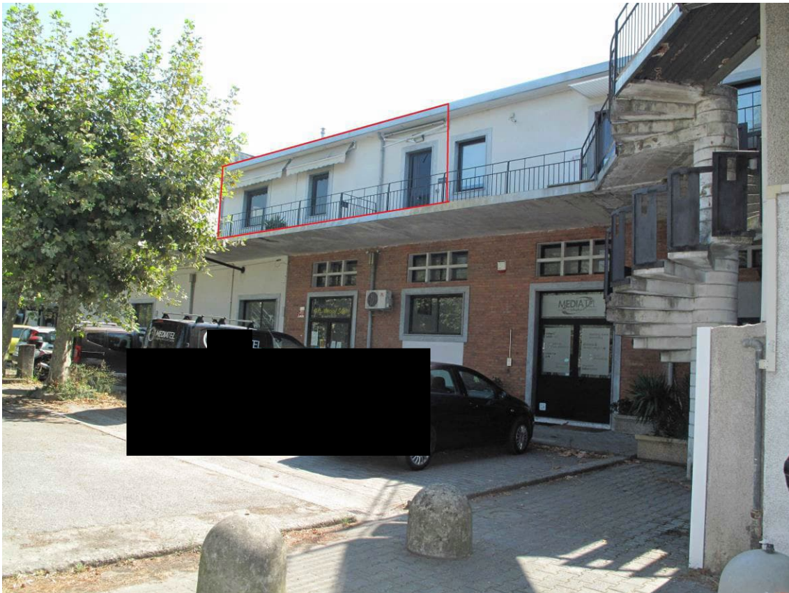
Foto 5. Esterno dal cortile interno
