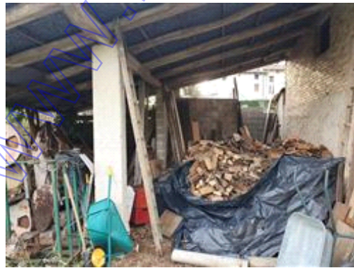
tettoia particolare interno
