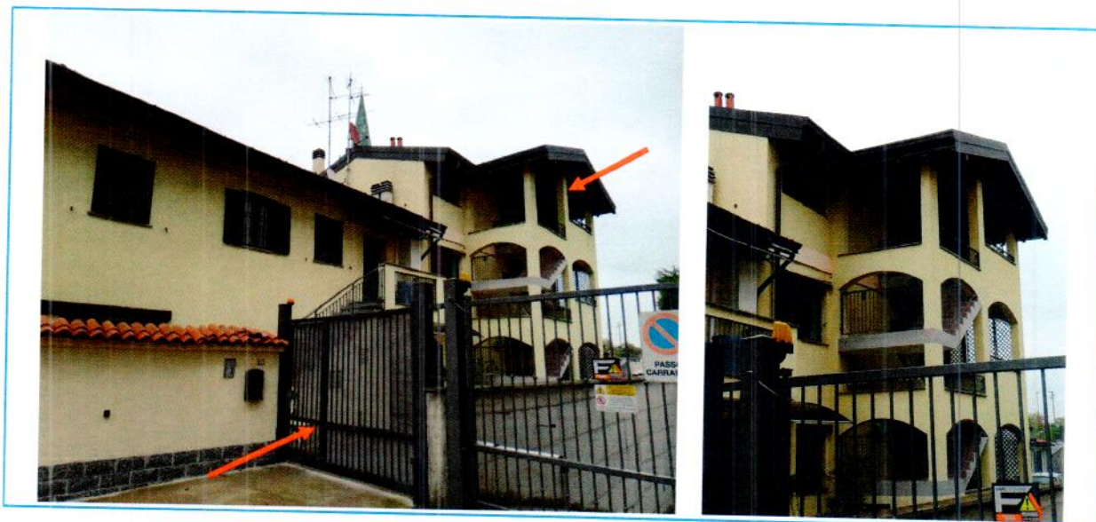
Fig. 4 - 5: vista fabbricato e accesso dalla strada, individuazione immobile
