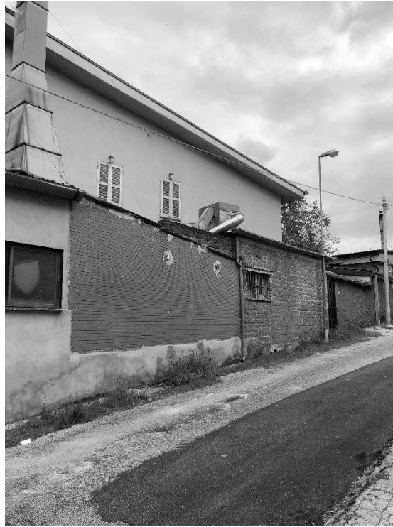
foto 5 – Vista lato sud (Ristorante)
