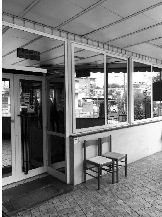
foto 7 – Ingresso ristorante dal porticato esterno
