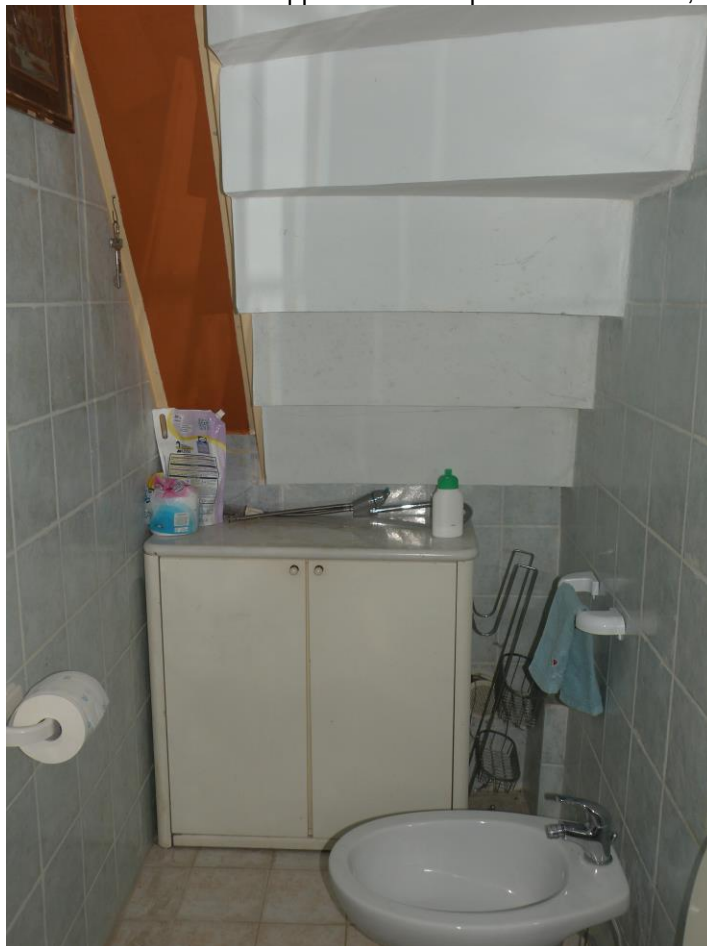
FOTO N°37: Vista interna dell'appartamento al piano seminterrato, bagno/2.
