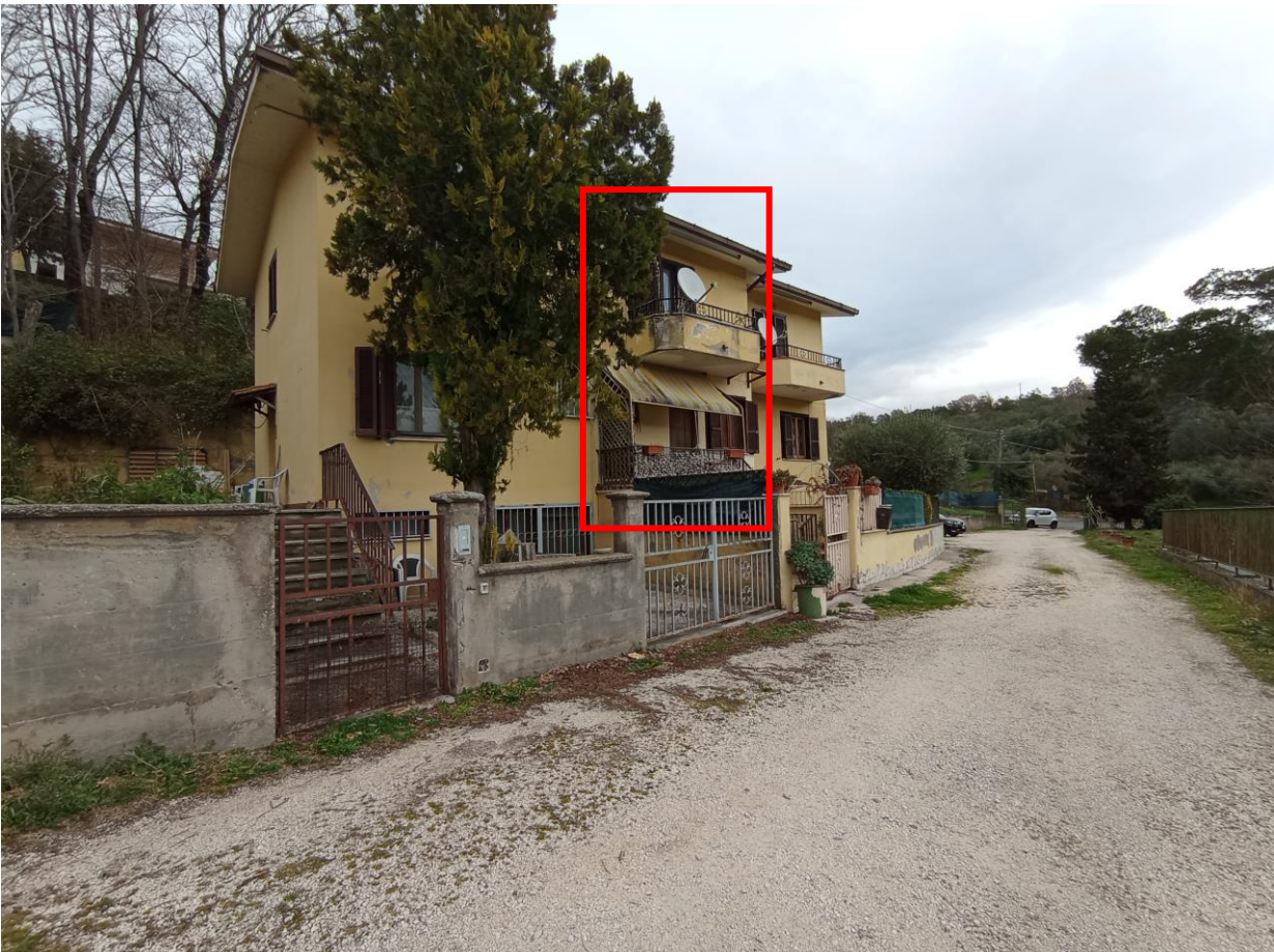
FOTO N°4: Vista esterna della corte comune/3.
