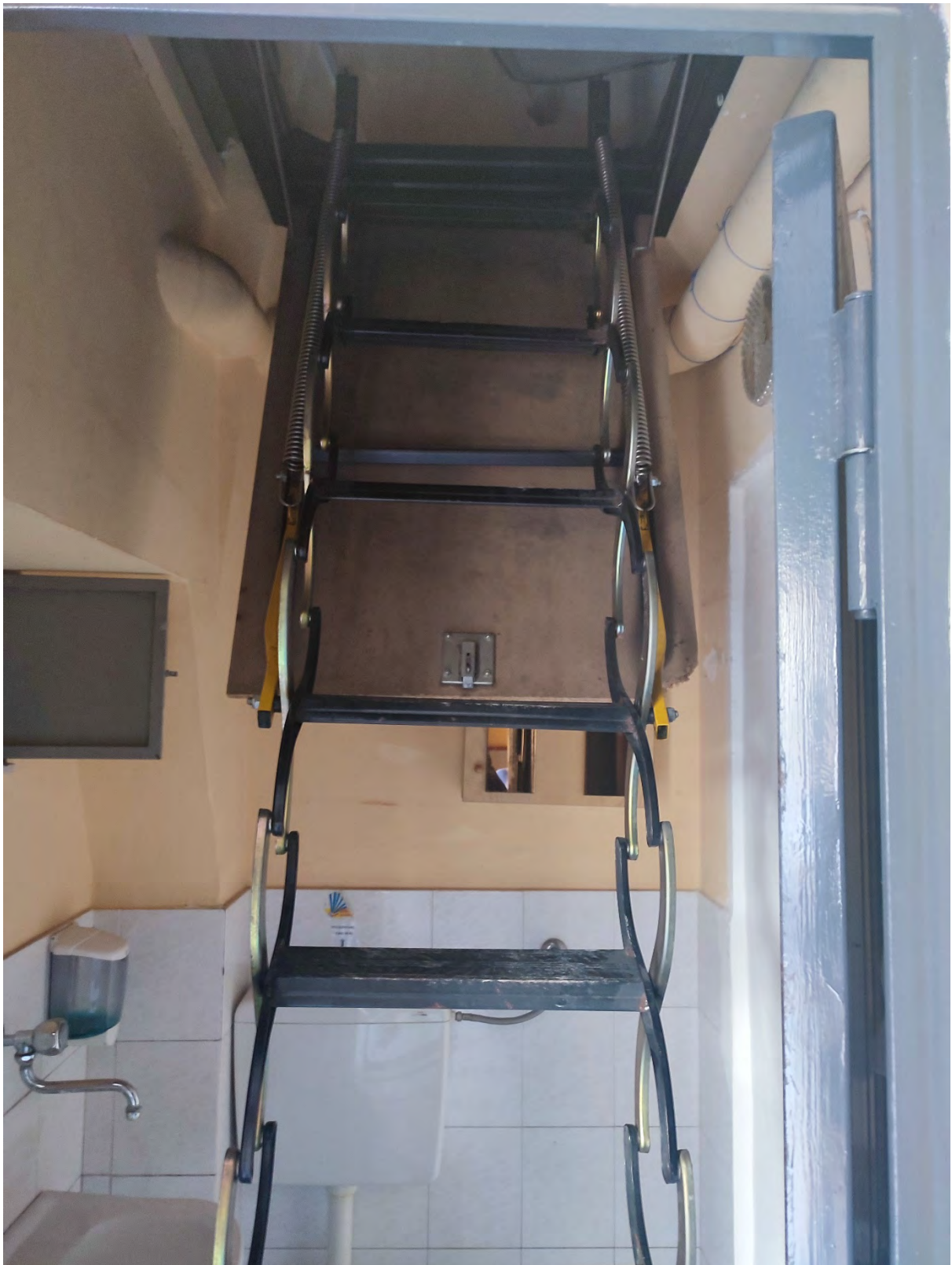
FOTO N. 7. Scala accesso soppalco.
