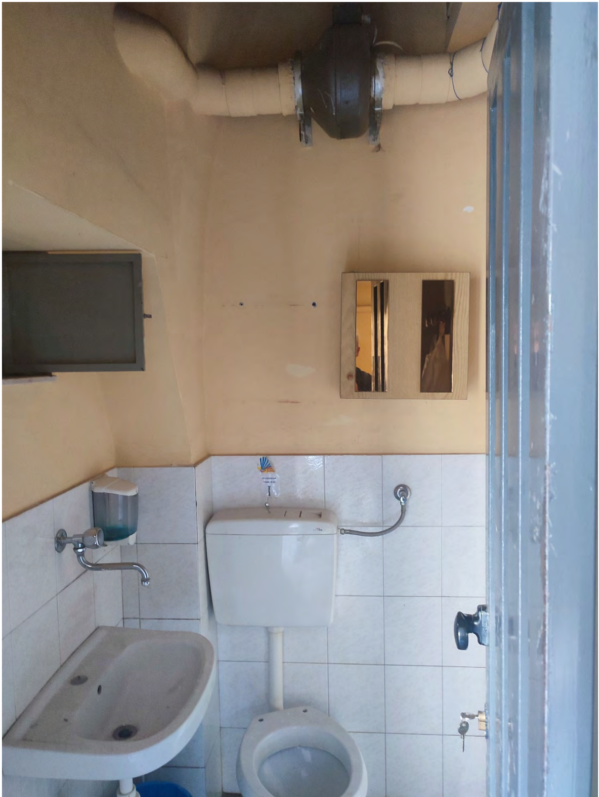
FOTO N. 6. Particolare interno wc.
