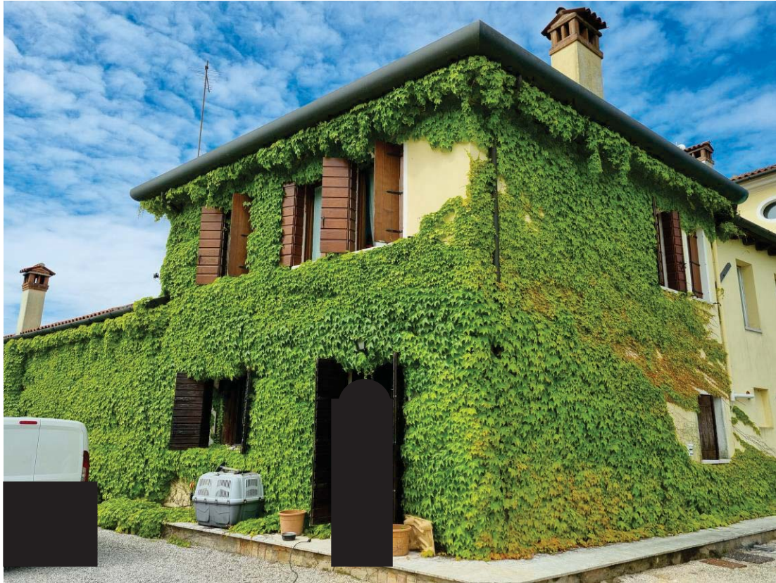
VISTA ESTERNA NORD-EST
