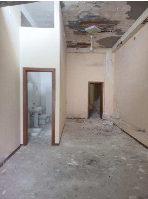
FO - 12: Interno deposito sub. 53
