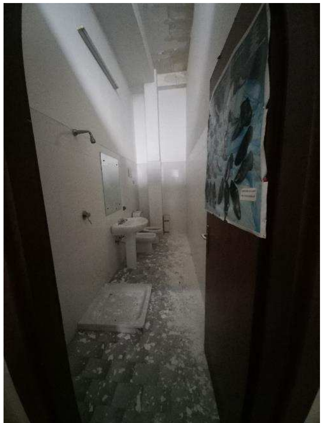
FO - 13: wc deposito sub. 53
