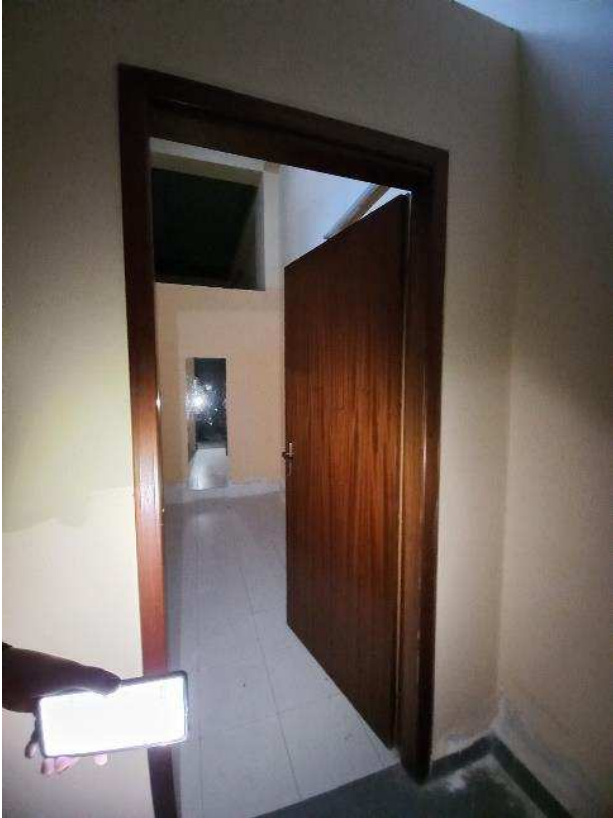
FO - 8: Locale ripostiglio interno deposito sub. 46
