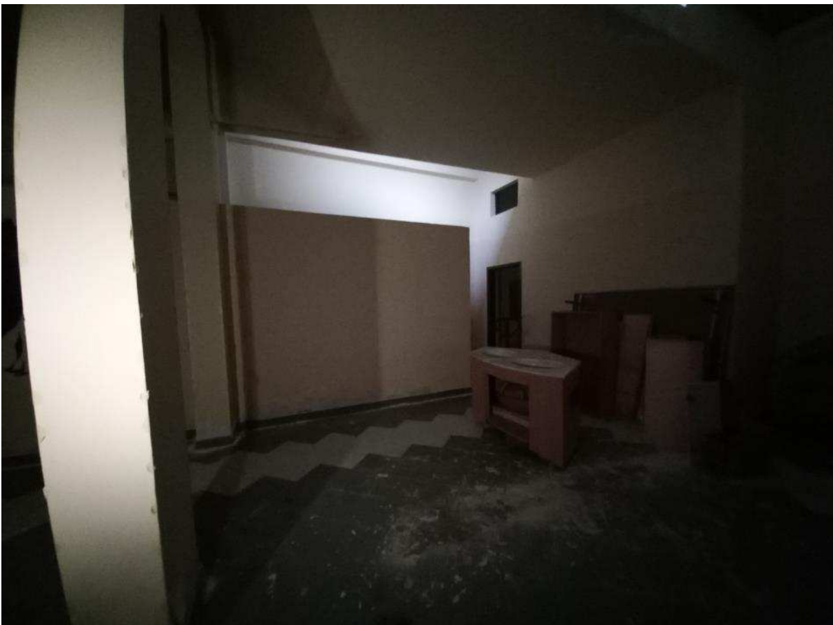
FO - 7: Interno deposito sub. 46
