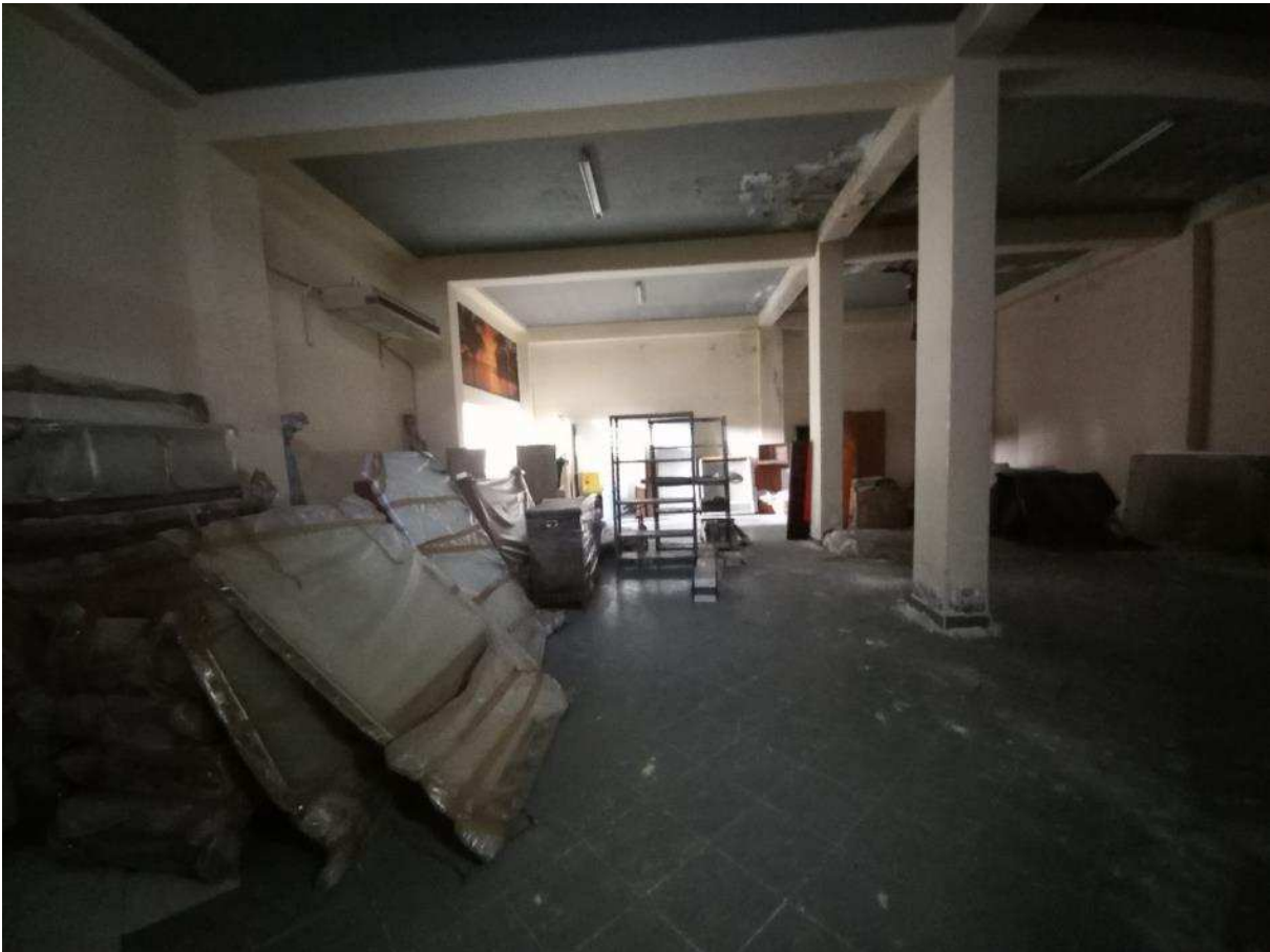
FO - 6: Interno deposito sub. 46
