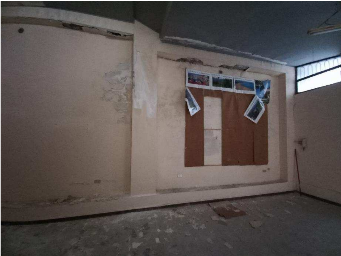
FO - 11: Interno deposito sub. 53
