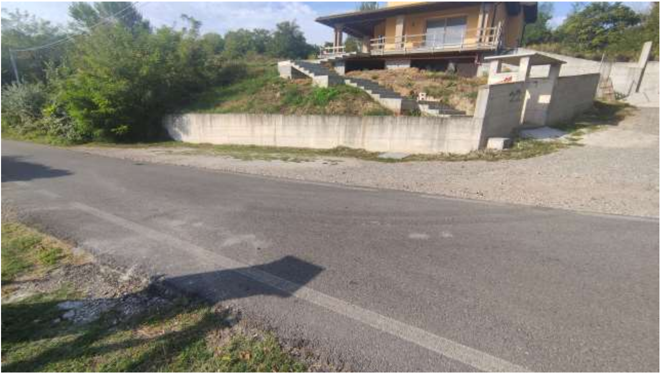
MAPPALI 945-946-942 (foto da n° 31 a n° 38) - Foto n° 31
