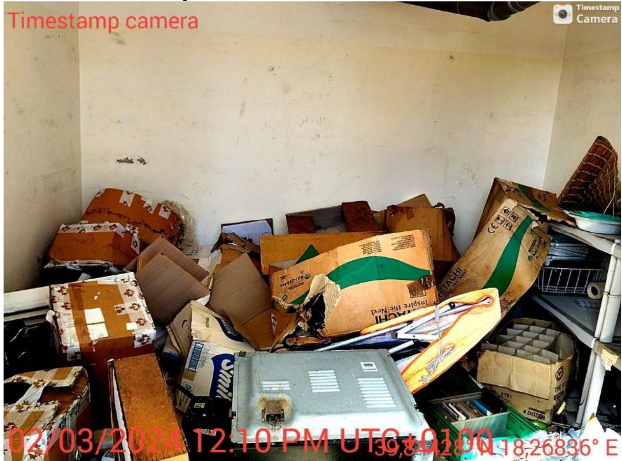
Fabbricati servizi comuni (rifiuti da rimuovere) - vista interna
