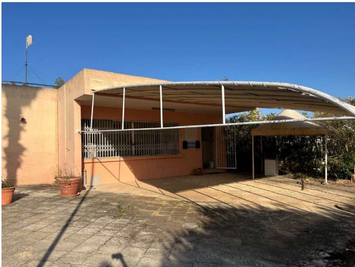
Fabbricato servizi comuni lato nord Accettazione-uffici
