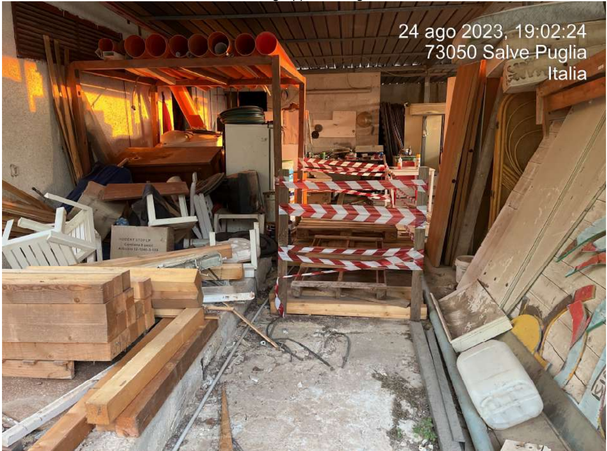
Area ex depuratore (dismesso) con materiale da rimuovere e smaltire - zona sud
