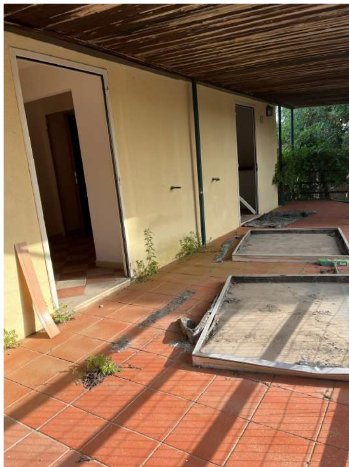
Unità fisse - bungalows in zona nord est - vista veranda esterna
