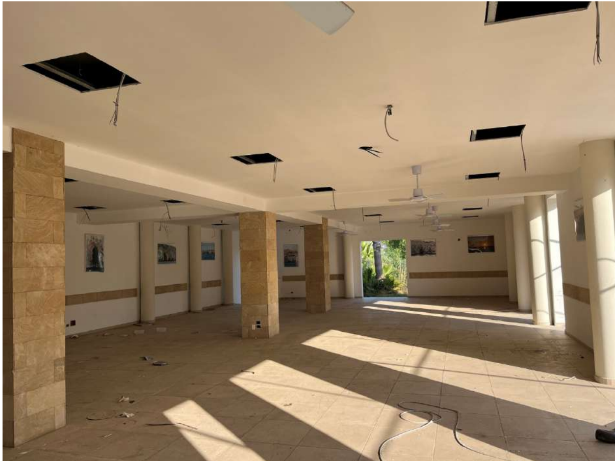
Fabbricato servizi comuni Ristorante self-service vista interna
