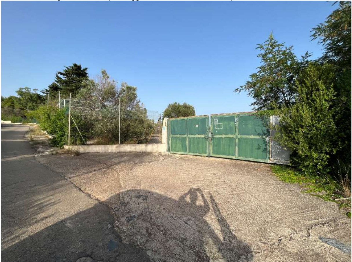
Portone di accesso secondario all'area campeggio a sud-ovest su strada comunale Contrada "Borgino"
