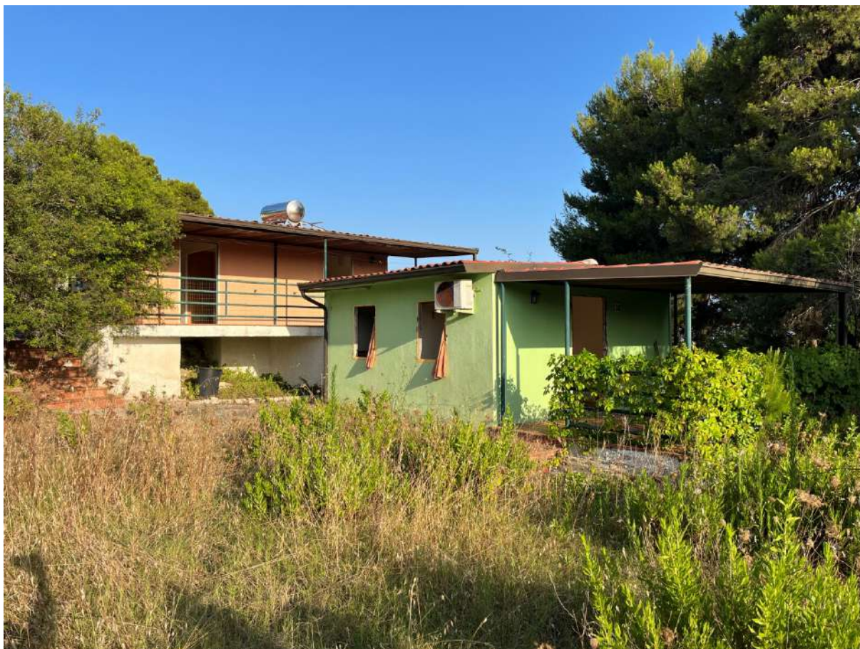
Unità fisse – bungalows zona nord est
