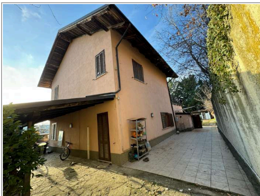
Foto n.4 prospetto nord ovest
