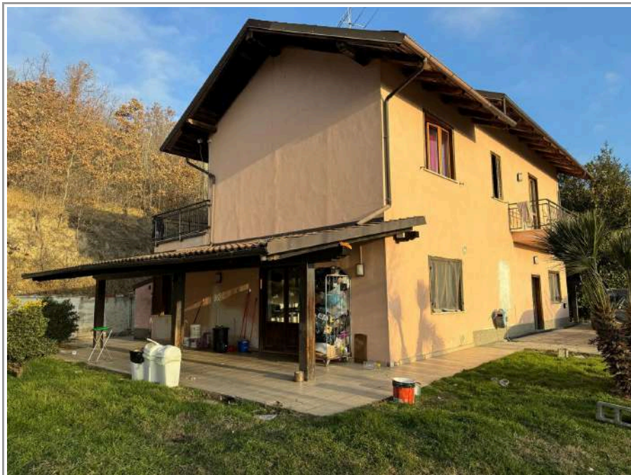
Foto n.2 prospetti sud e ovest
