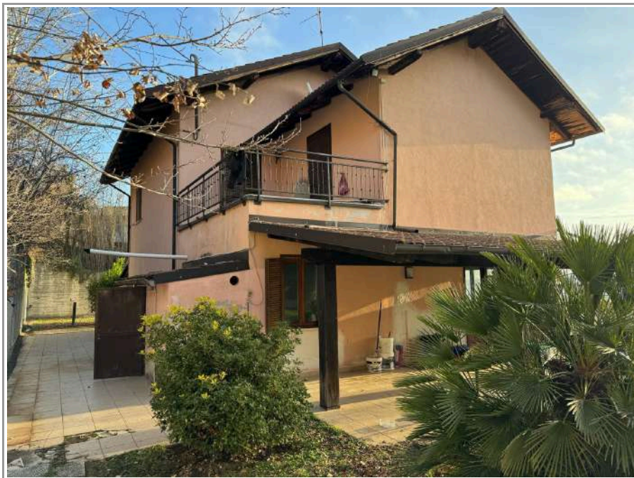
Foto n.3 prospetto sud ovest
