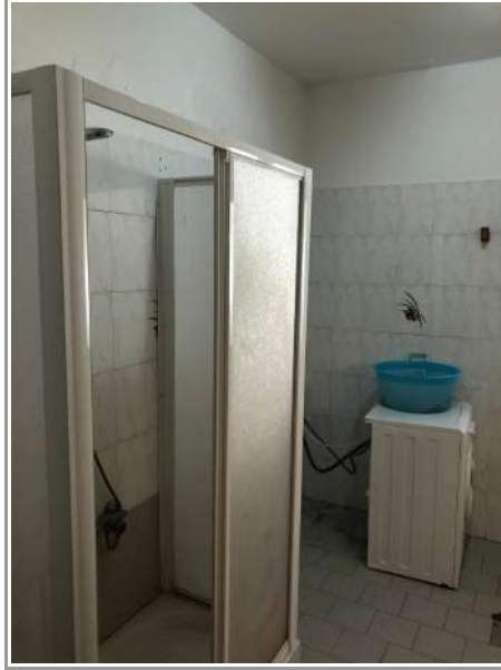
Foto n. 9 e 10 P.T. bagno
