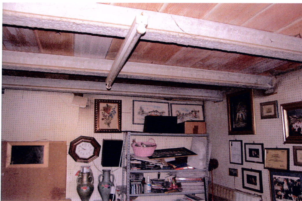
VISTA INTERNA UNITA IMMOBILIARE "C"
