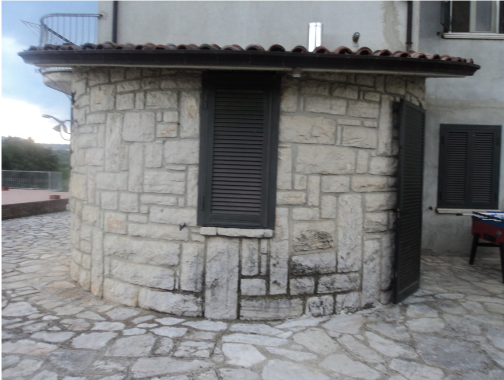
PIANO TERRA – Vista esterna locale caldaia
