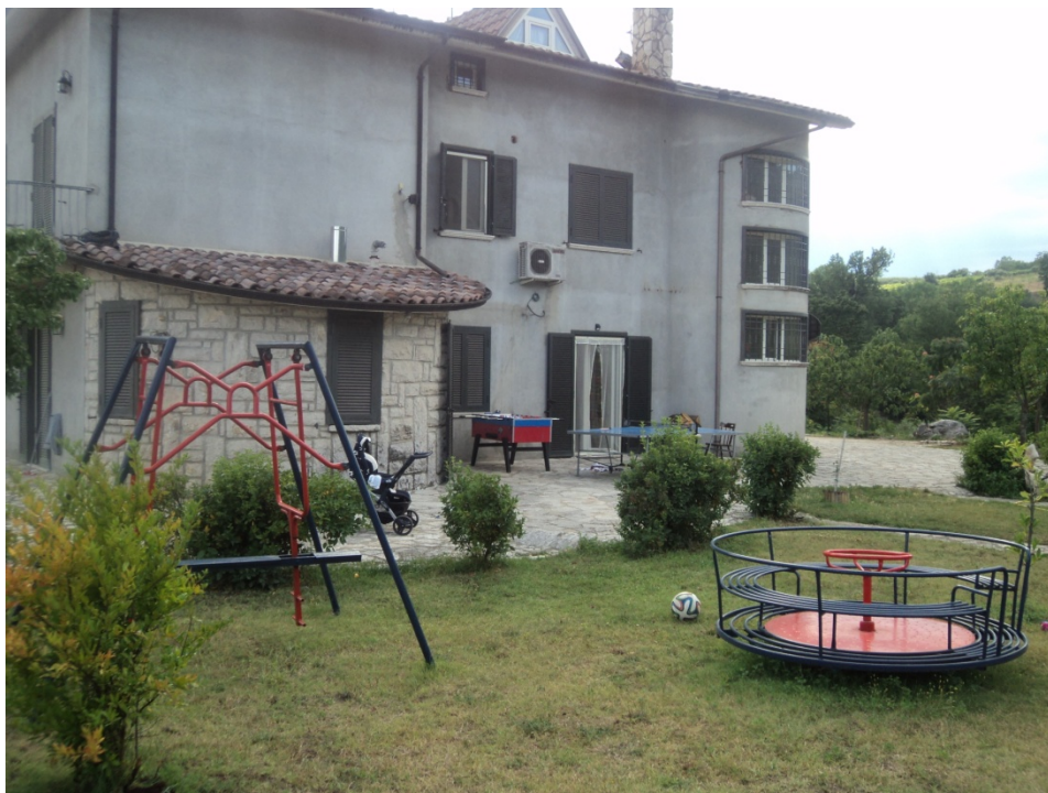
PIANO TERRA – Vista posteriore
