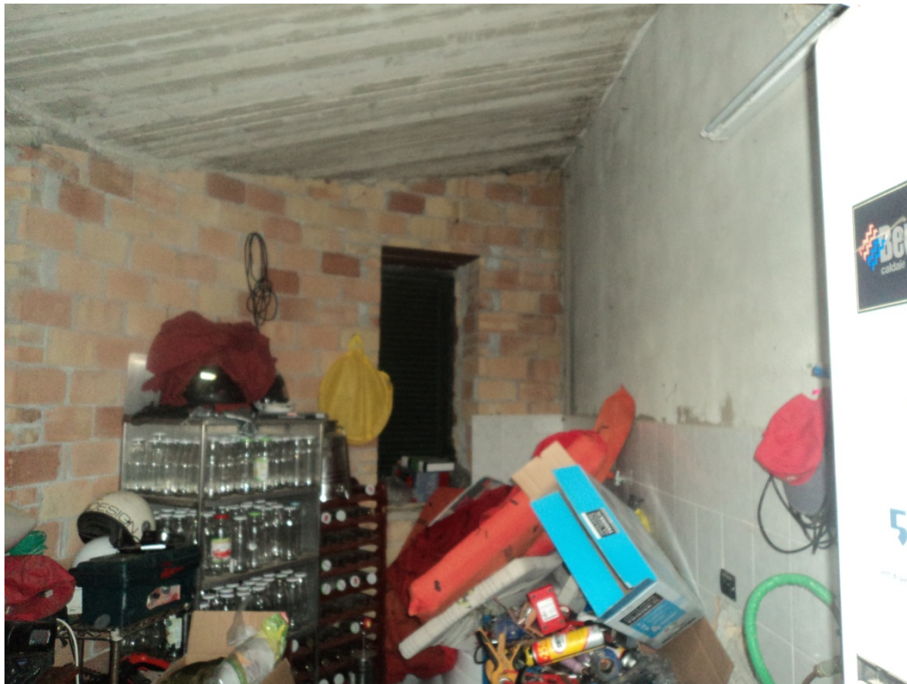
PIANO TERRA – Vista interna locale caldaia
