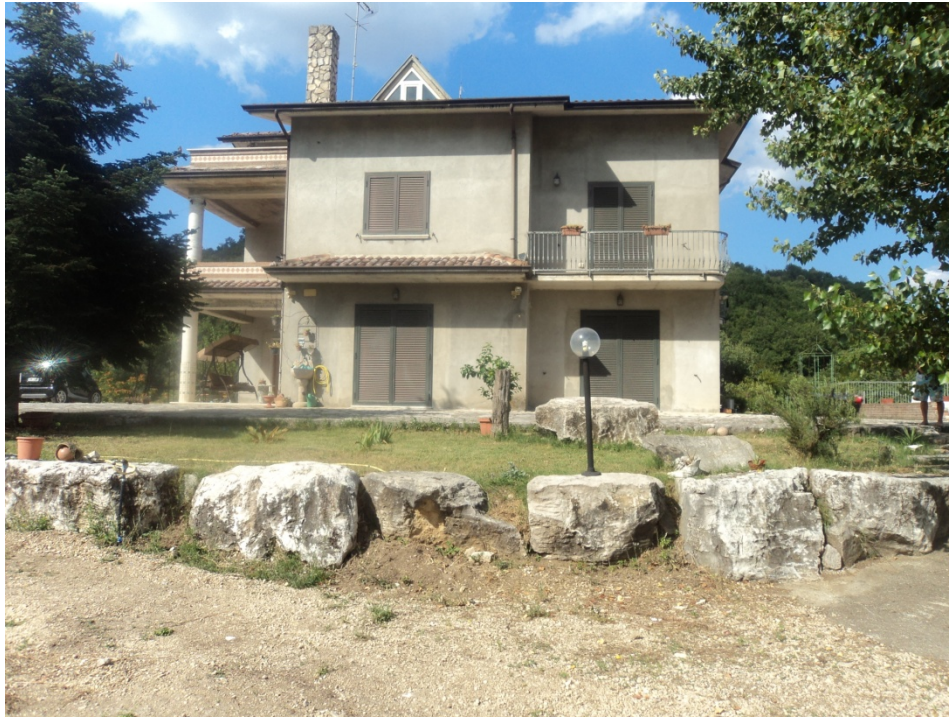
PIANO TERRA – Vista principale
